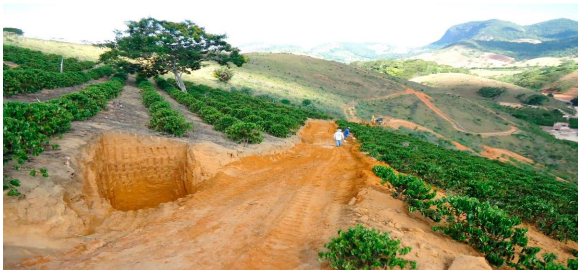
Figura 111 – Caixa seca e trecho de estrada vicinal recuperada
