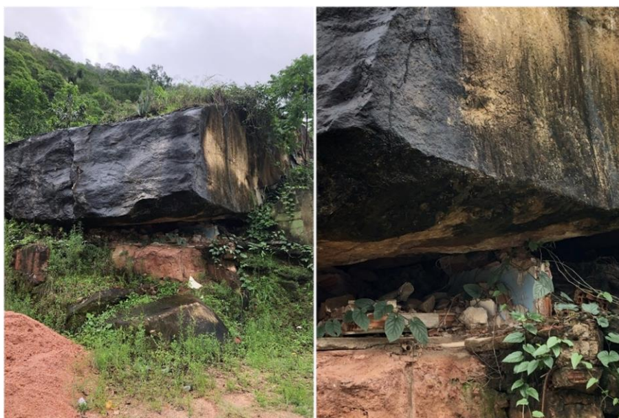
Figura 30 – Casa soterrada por movimento gravitacional de massa na cidade de Mimoso do Sul
