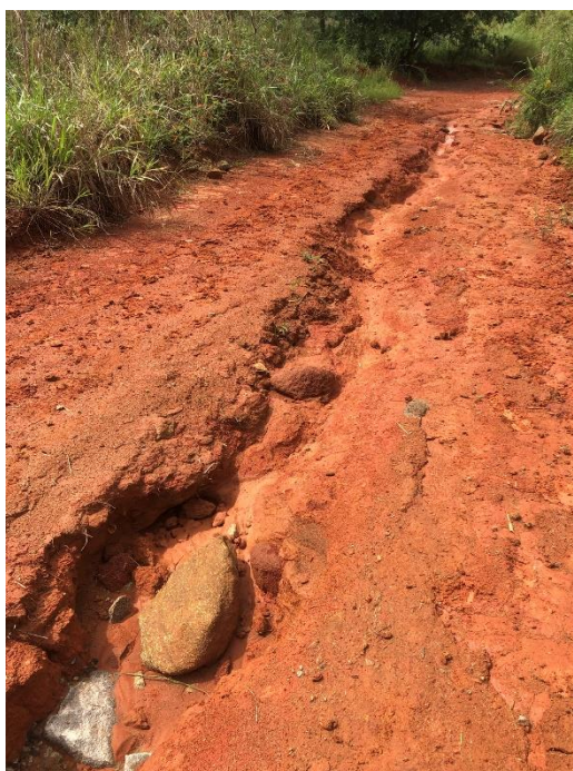
Figura 116 – Sulco de erosão em estrada vicinal da região
