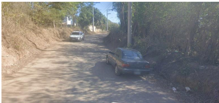
Figura 2: Situação do Segmento na ES-264, próximo a Serra Mar
