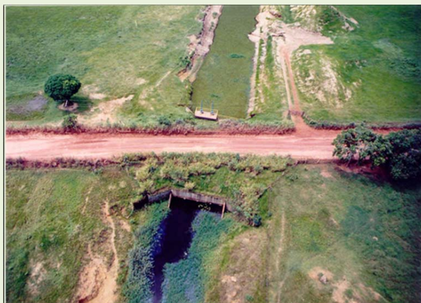
Figura 2-6: Canal C3/ Comporta na Estrada Bebedouro/Regência.
