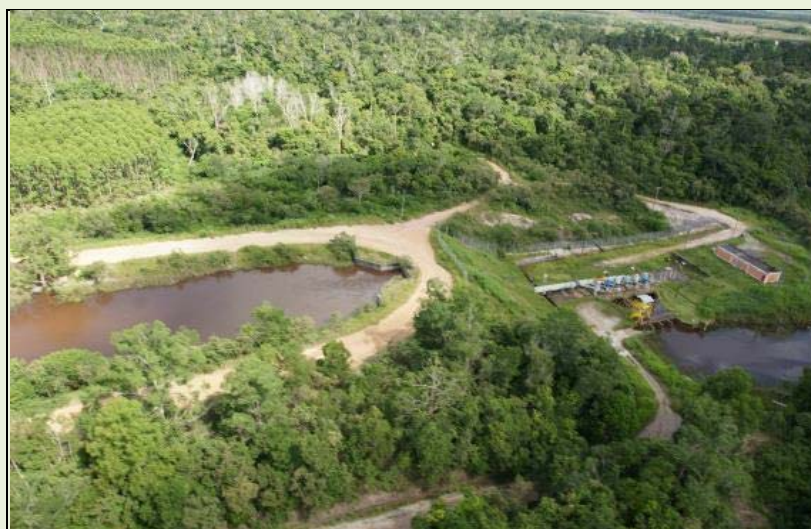
Figura 2-16: Captação de águas no Córrego Palmital para abastecimento do Complexo Santa Joana/Pavor.
