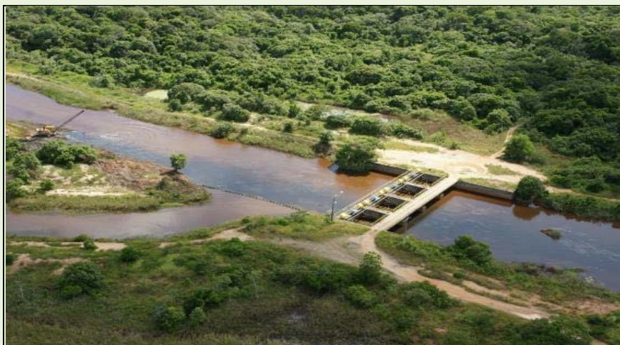
Figura 2-11: Detalhes da Barragem Móvel, com o Canal C5 (alto à esquerda) e rio Gimuhuna (abaixo à esquerda) e continuidade do rio Riacho (lado direito).
