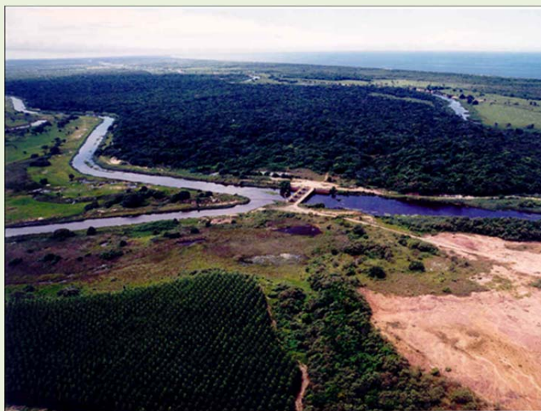
Figura 2-17: Detalhes da Barragem Móvel, dando continuidade à porção final do rio Riacho (lado direito) e vista parcial do Rio dos Comboios (acima à direita).
