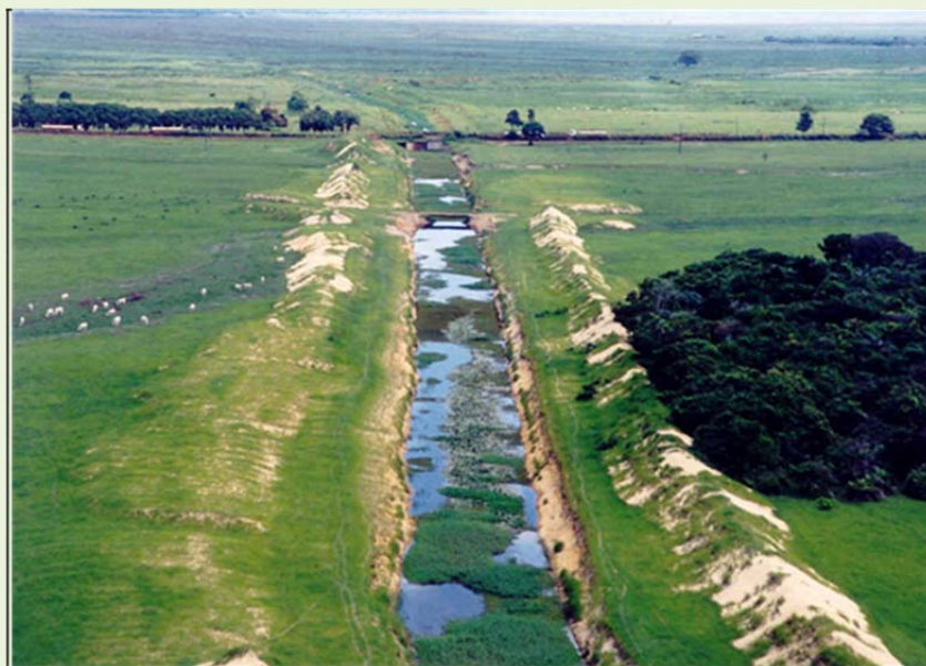
Figura 2-5: Canal C3 com vistas, ao fundo, da travessia na Estrada Bebedouro/Regência.
