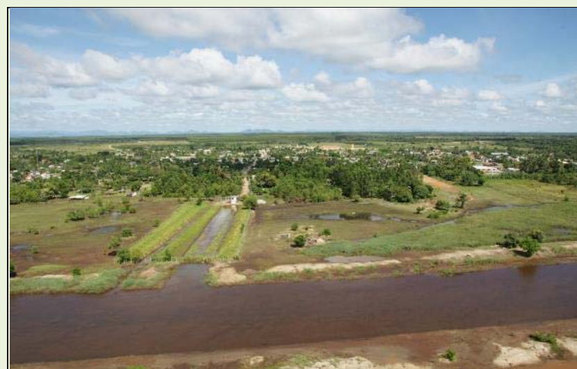
Figura 2-9: Captação de água na Vila do Riacho a partir do Canal C5.
