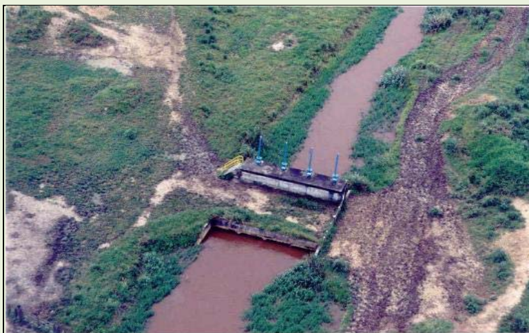
Figura 2-3: Comporta no Canal Bananal do Sul.
