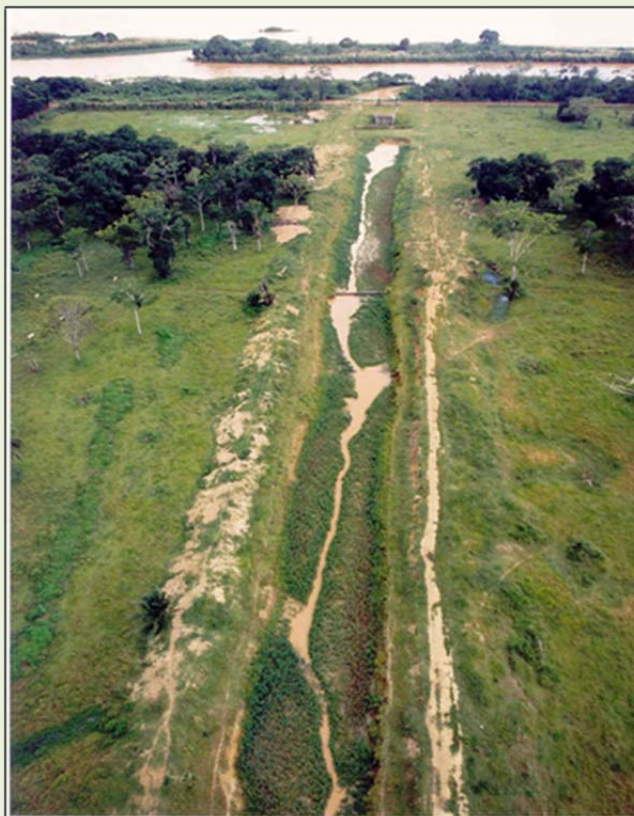
Figura 2-2: Canal de ligação entre o Rio Doce/ Canal Bananal do Sul – Construção nova (2 km).
