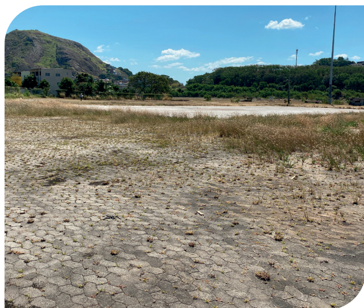
Área industrial onde se pretende instalar o TGL.
