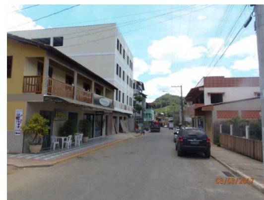
Rua principal de Ponto Alto, asfaltada e com rede pluvial.
