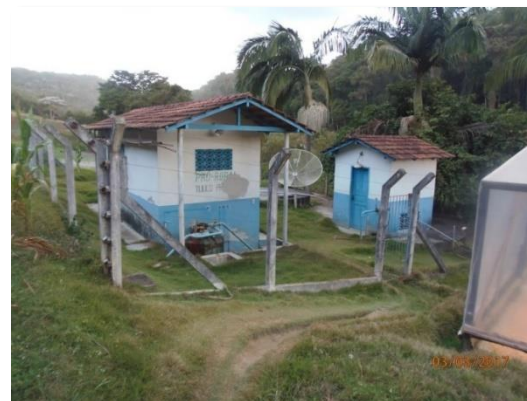
Estação de tratamento de água de Tijuco Preto.
