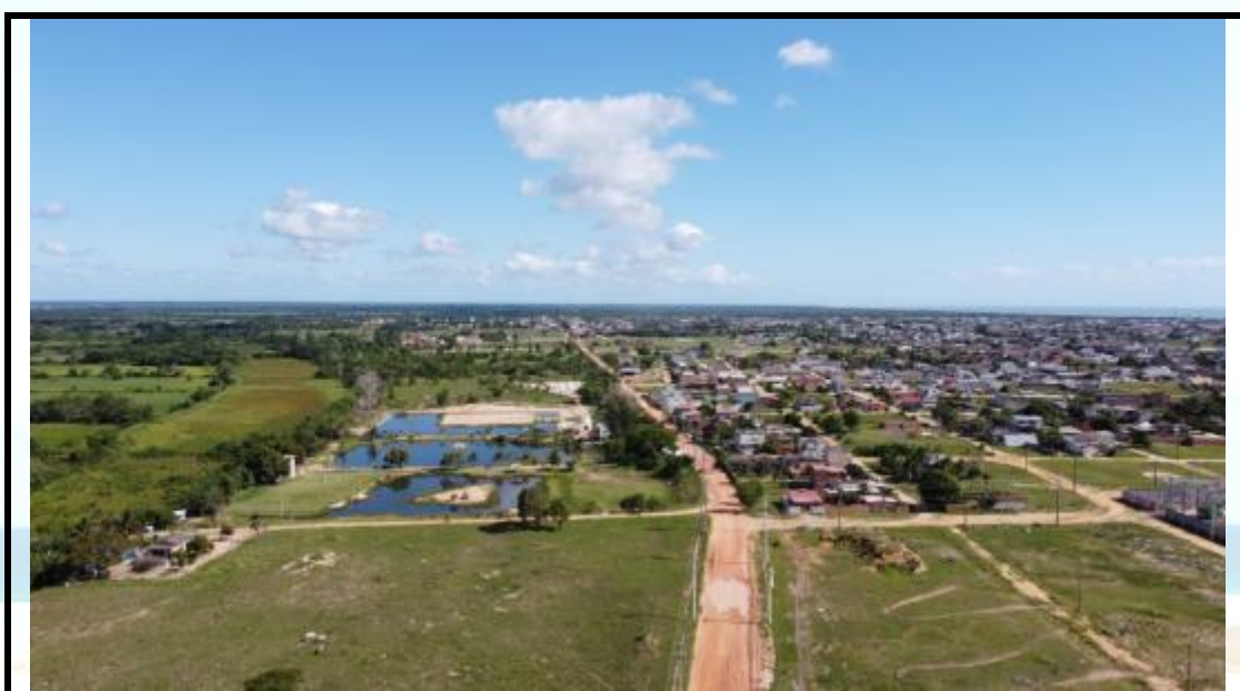
Figura 11-62: Eixo da rodovia que será asfaltada, com edificações nas margens. Trecho IV.
