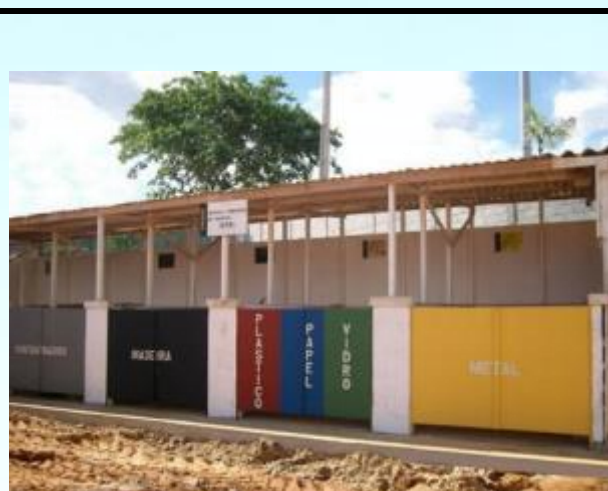
Foto 9 -12 – Exemplo do espaço designado para a segregação e descarte adequado de resíduos gerados durante a construção.
