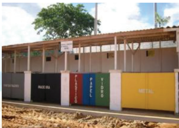
Foto 9 -7: Exemplo do espaço designado para a segregação e descarte adequado de resíduos gerados durante a construção.
