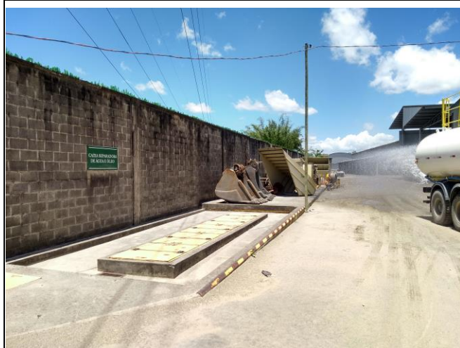
Fotos “21” e “22” – Vista de outras partes da área onde estão situadas as instalações de apoio do empreendimento, tendo-se na foto à esquerda o local do Sistema SAO (separador água-óleo), bem dimensionado, e tendo-se na foto à direita o local das baias de segregação de resíduos sólidos (e oleosos acondicionados em bombonas), reservando-os para posterior destinação adequada.
