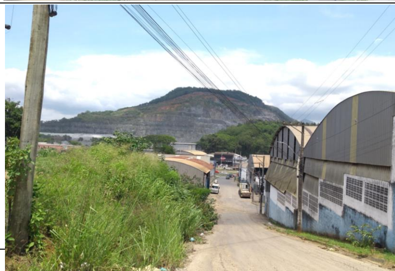
Foto "09" – Outra vista do morro onde se situa a frente de lavra da empresa, observando-se a partir do bairro Nova Valverde, podendo-se notar que as bancadas de extração que estão sobre a encosta do morro se encontram praticamente "de frente" para o bairro, o que evidencia a necessidade premente de que a empresa efetue os eventos de detonação de rocha no local de maneira criteriosa, e adotando as medidas pertinentes para promover uma minimização dos possíveis impactos que normalmente são gerados, visando reduzir os efeitos negativos que podem chegar aos bairros vizinhos.
