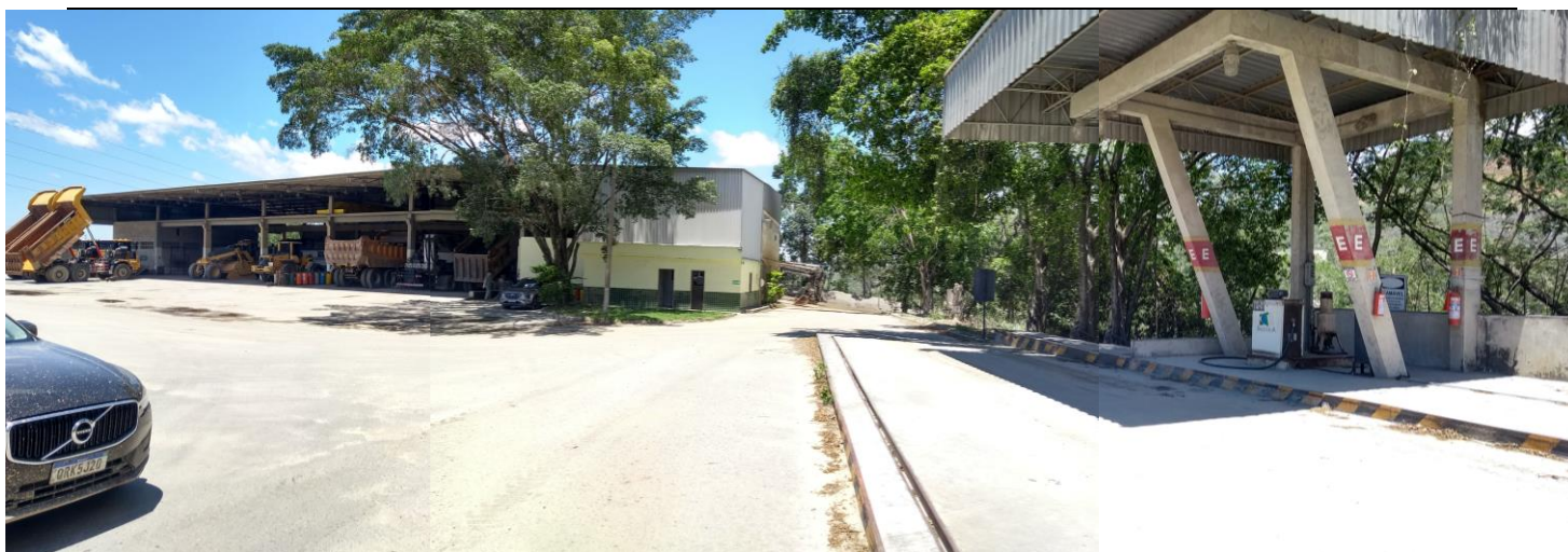
Foto “20” – Vista geral de parte da área onde estão situadas as instalações de apoio do empreendimento, localizadas próximo à planta do beneficiamento de rocha, tendo-se à esquerda da foto o local da oficina mecânica (que tinha piso impermeabilizado e interligação com Sistema SAO), e também, mais à direita da foto, o ponto onde se situa um dos tanques subterrâneos de abastecimento de combustível (com sua bomba, canaletas, piso de concreto e cobertura).
