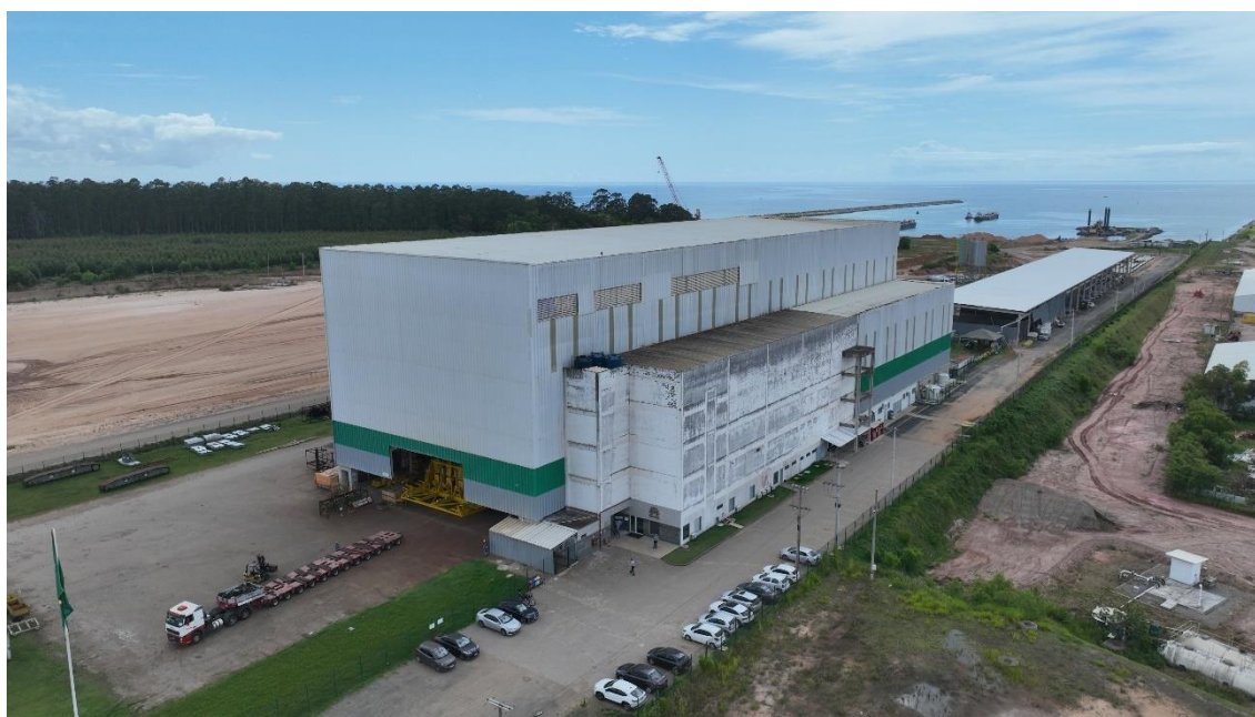
Figura 4-2: Estrutura de apoio, utilizada como canteiro de obras principal, Base de Apoio Porto. Ao fundo observa-se a Central de Concreto.
