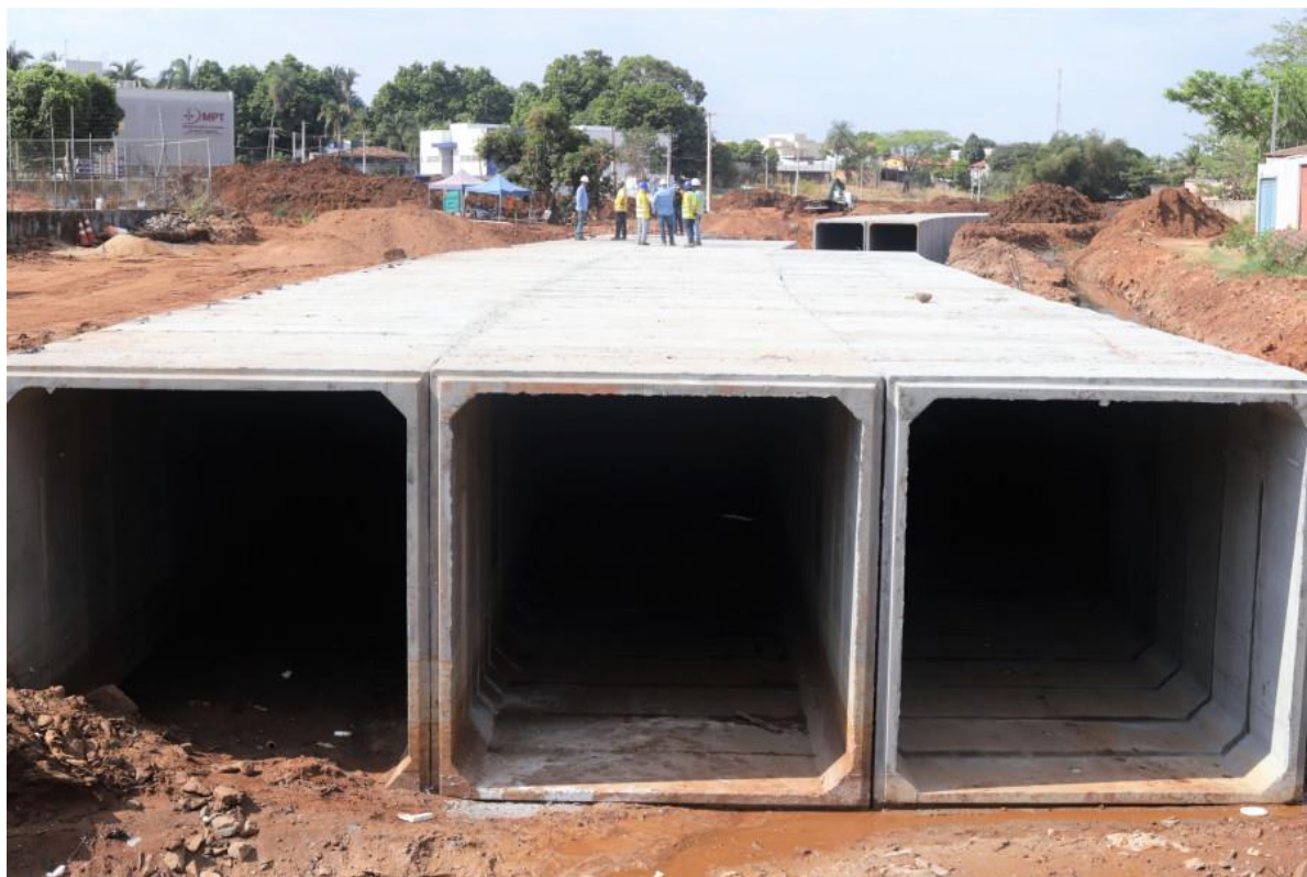
Figura 4-40: Pré-moldados utilizados em obra de canalização. Fonte: Araguaína Notícias, 2021.
