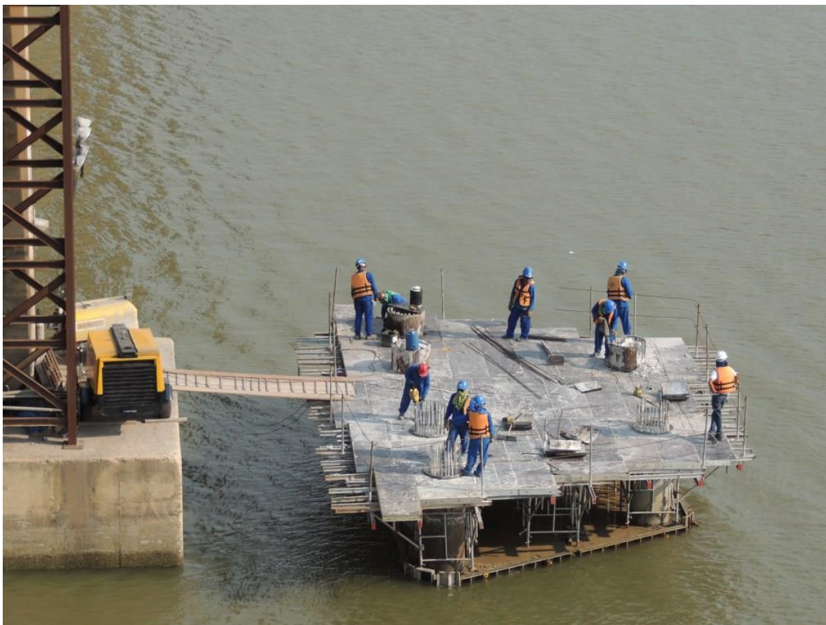
Figura 4-73: Construção superestrutura de dólfins. Fonte: Dynamis Techne, 2024.
