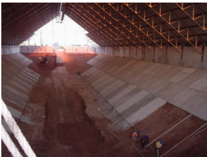
Figura 4-64: Obra de construção de piso em armazém. Fonte: Silo Campo Construtora, 2024.
