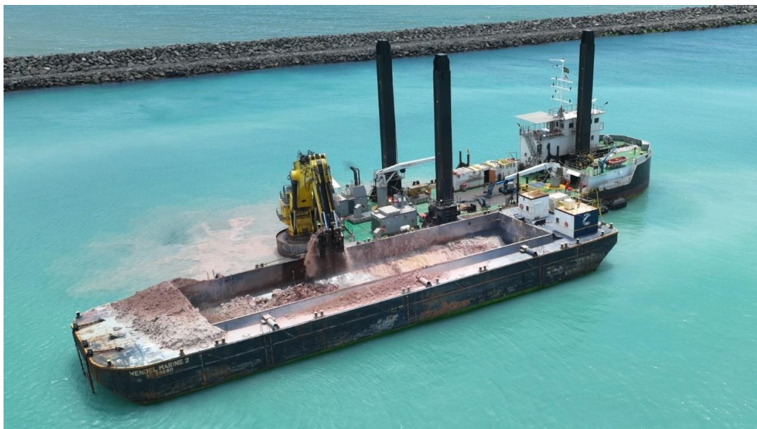
Figura 4-26: Dragagem backhoe despejando material de dragagem no batelão Fonte: Acervo Imetame.
