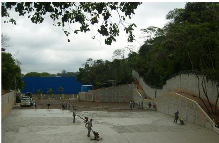
Figura 4-55: Construção de piso em concreto armado. Fonte: CT Guedes, 2024.
