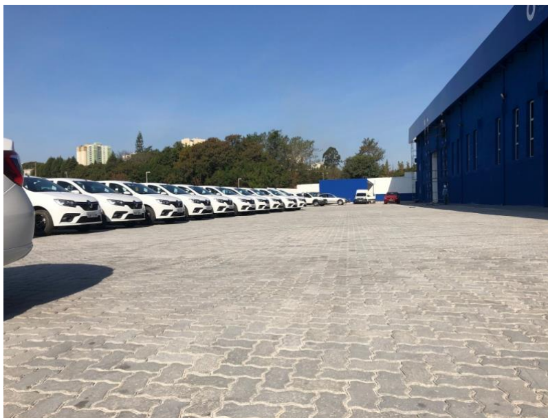
Figura 4-52: Pátio externo de veículos em piso intertravado. Fonte: Cemare, 2024.
