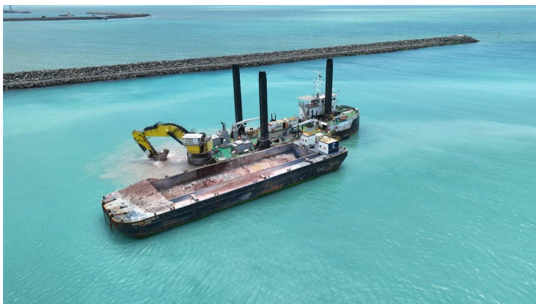
Figura 4-25: Draga backhoe em operação. Fonte: Acervo Imetame.
