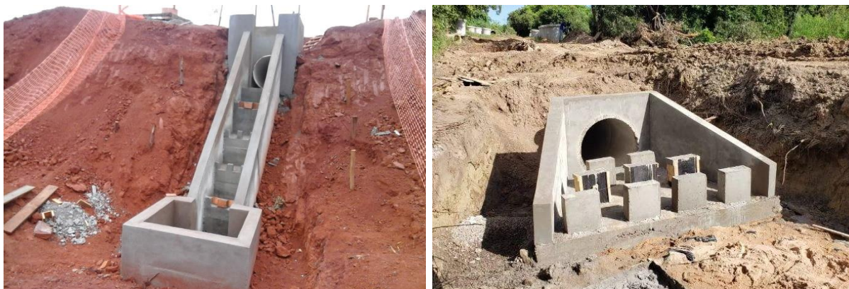
Figura 4-37: Sistemas de dissipação de energia.
