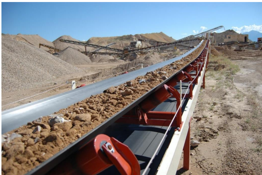
Figura 4-68: Transportador por correia. Fonte: Apelmat, 2024.
