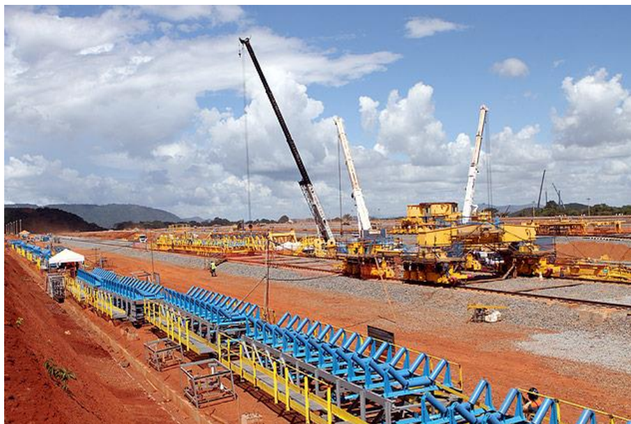
Figura 4-69: Montagem de Transportador de Correias. Fonte: Varlei di Comércio e Representações, 2016.
