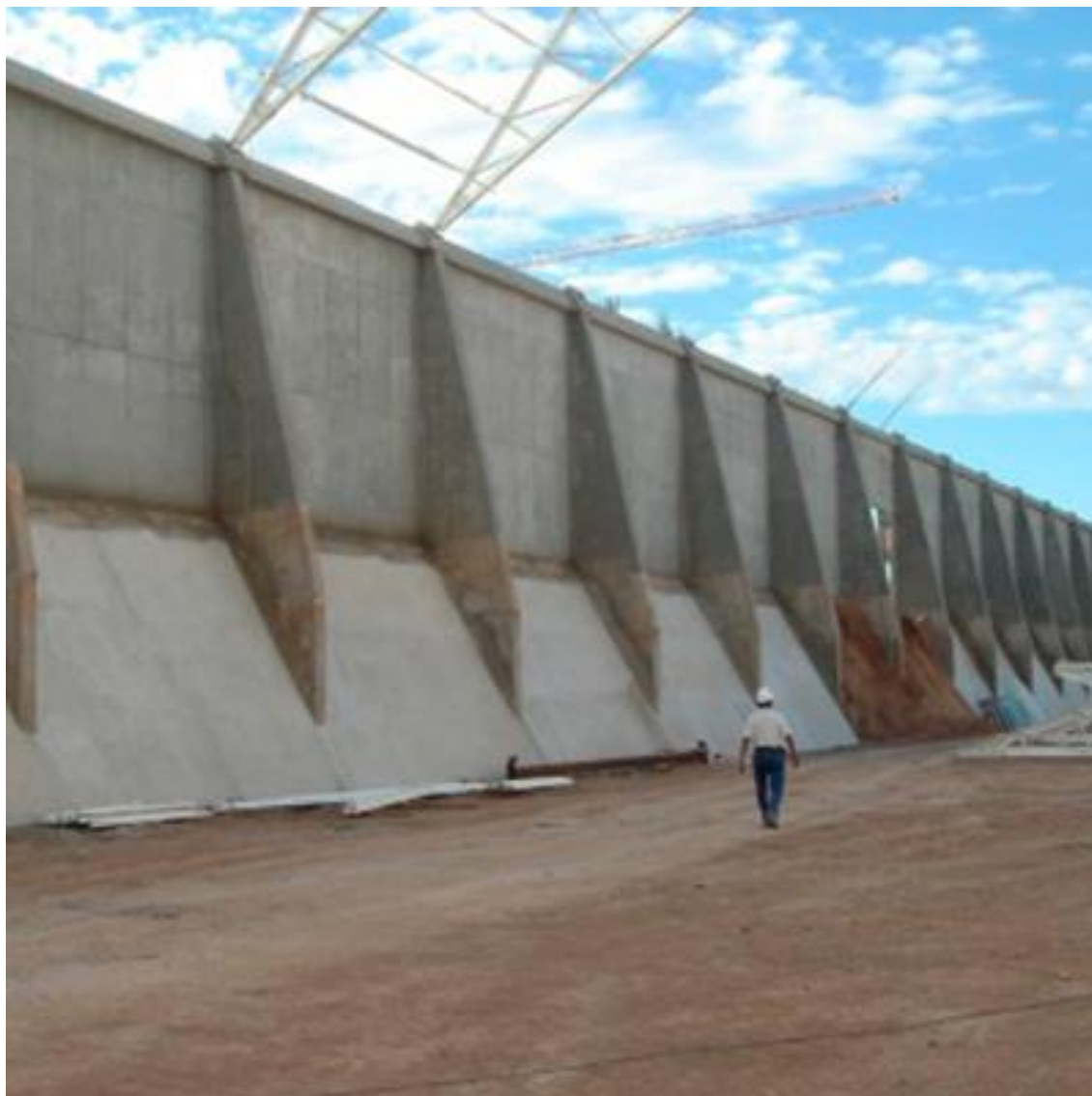
Figura 4-66: Obras de estrutura de armazém. Fonte: Geoconcret, 2024.
