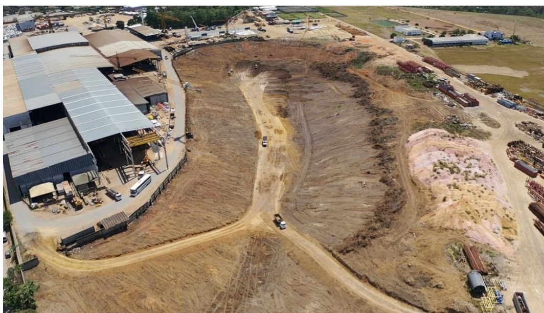
Figura 4-23: Vista aérea de área de expansão da Imetame Metalmecânica, que poderá receber o material excedente da terraplanagem do Imetame Logística Porto. Fonte: Imetame, 2024.
