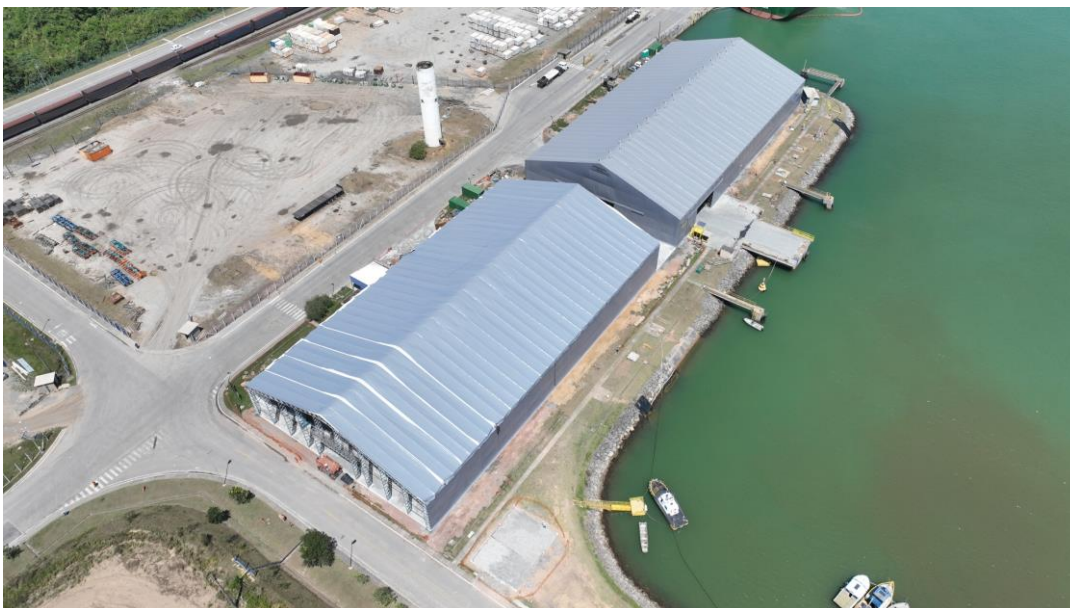
Figura 4-62: Instalação de lona em armazém inserido no pátio da Portocel. Fonte: Acervo Imetame.
