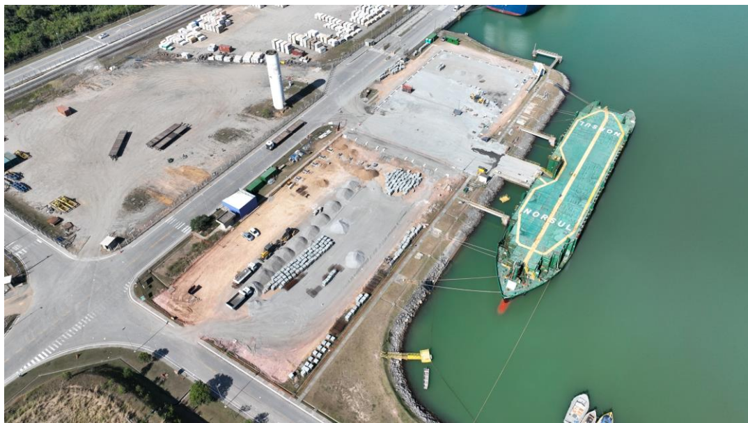
Figura 4-60: Preparo da área para início da montagem de armazém em lona no pátio da Portocel. Fonte: Acervo Imetame.
