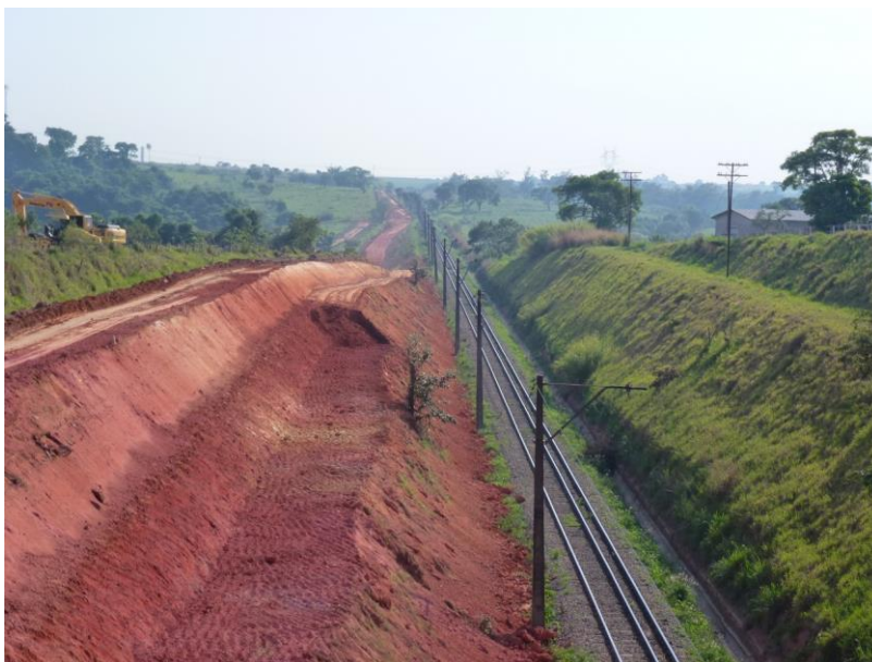
Figura 4-22: Obras de terraplanagem para ramal ferroviário. Fonte: Wikimedia, 2012.
