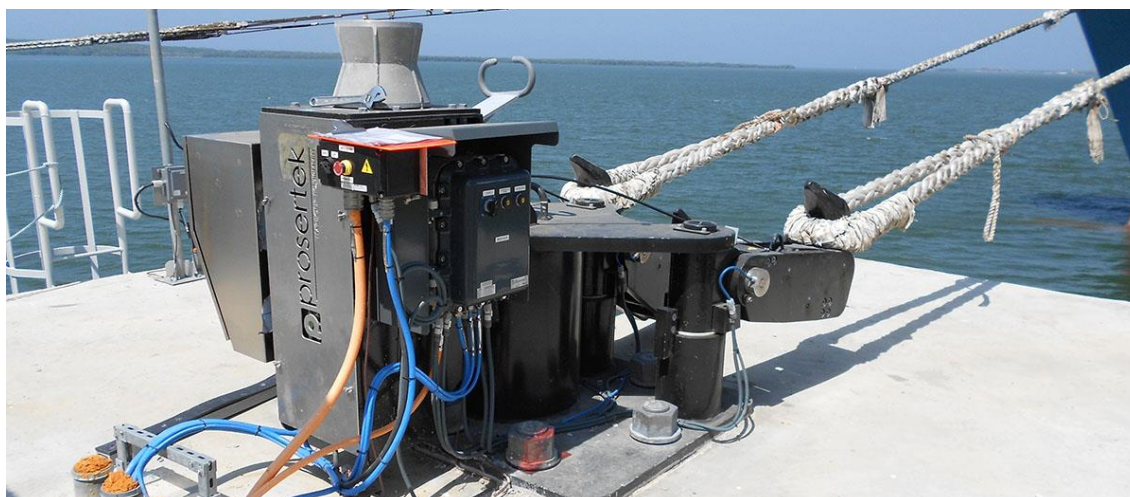
Figura 4-74: Cabeço com ganchos e sistema de soltura rápida em dólfin de amarração. Fonte: Supra Bakti, 2021.
