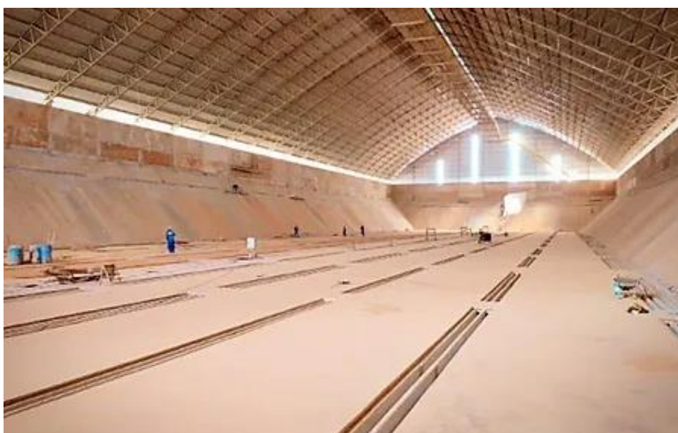
Figura 4-65: Interior de armazém graneleiro. Fonte: Engebel, 2024.
