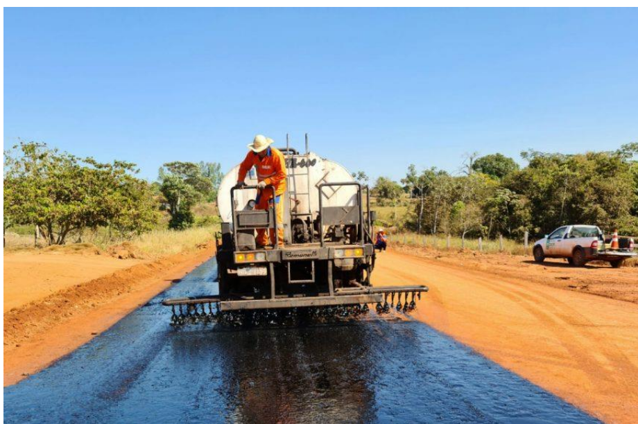
Figura 4-56: Imprimação. Fonte: Governo de Rondônia, 2021.
