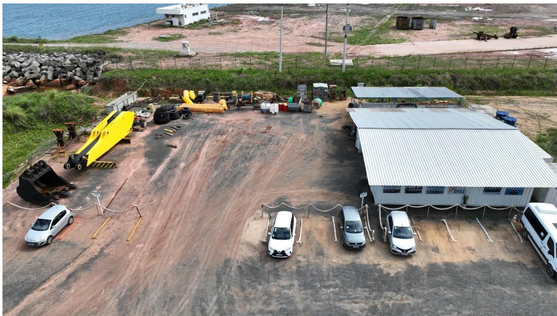
Figura 4-3: Canteiro de obra avançado, utilizado como apoio à dragagem. Fonte: Acervo Imetame.
