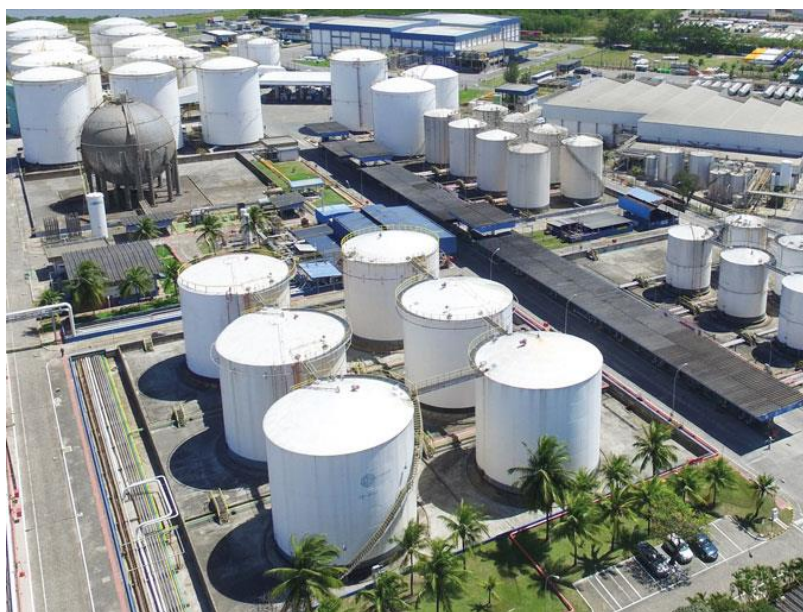
Figura 4-76: Terminal de combustíveis em Suape. Fonte: Portos e Navios, 2017.
