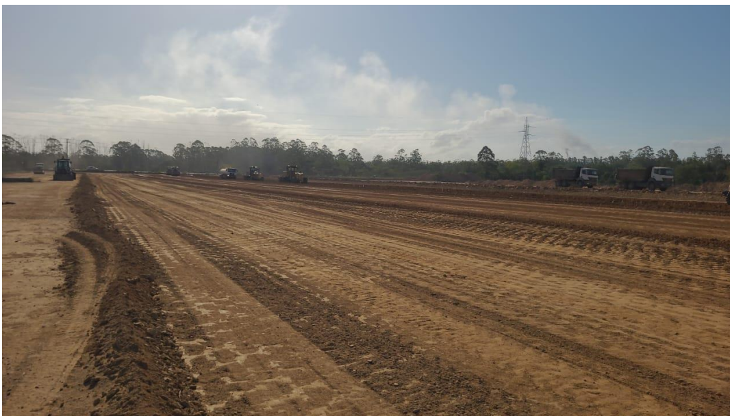
Figura 4-20: Obras de Terraplanagem do Imetame Logística Porto. Atividades para expansão seguirão o mesmo padrão.
