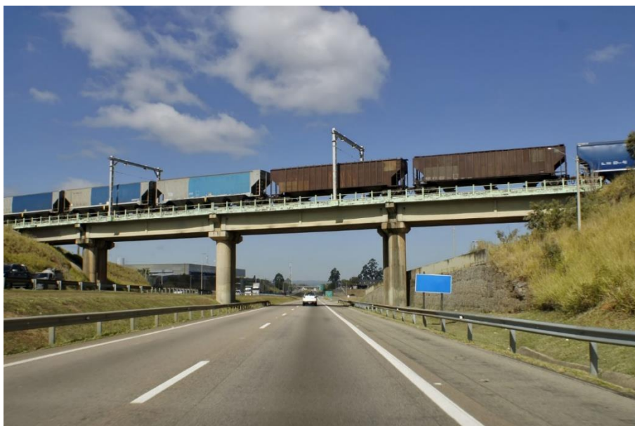
Figura 4-91: Viaduto ferroviário sobre rodovia. Fonte: O Especialista, 2021.
