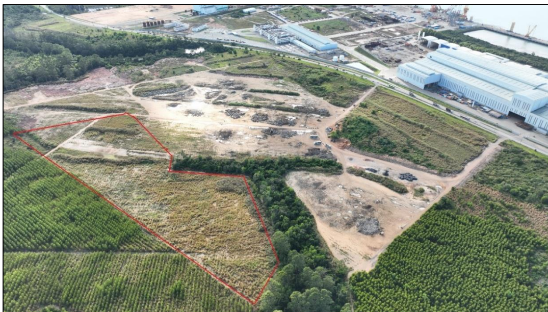
Figura 4-21: Imagem aérea da área do Pátio de estocagem temporário de produtos extrativos de origem mineral em bruto (solo).
