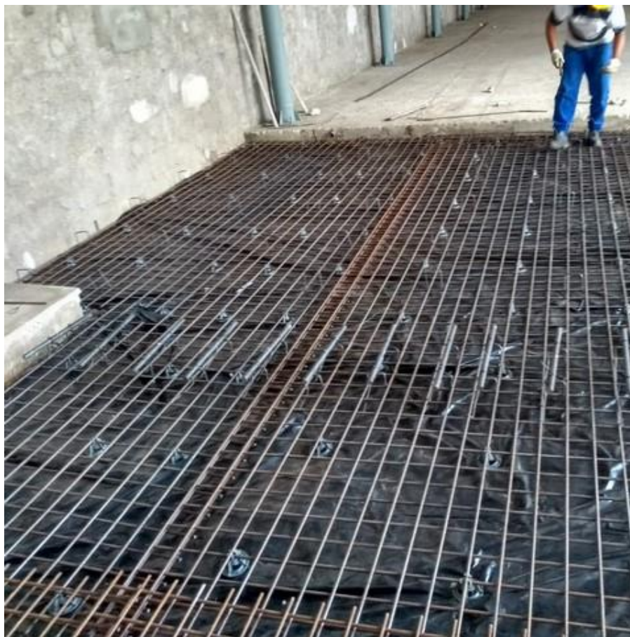
Figura 4-53: Preparação de piso para concretagem. Fonte: Axima, 2024.
