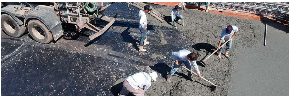
Figura 4-54: Processo de concretagem de piso. Fonte: Engenharia de Superfície, 2019.
