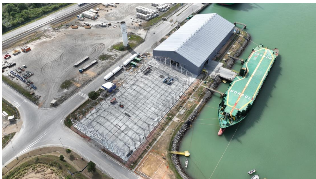
Figura 4-61: Montagem de estrutura metálica de armazém em lona no pátio da Portocel. Fonte: Acervo Imetame.
