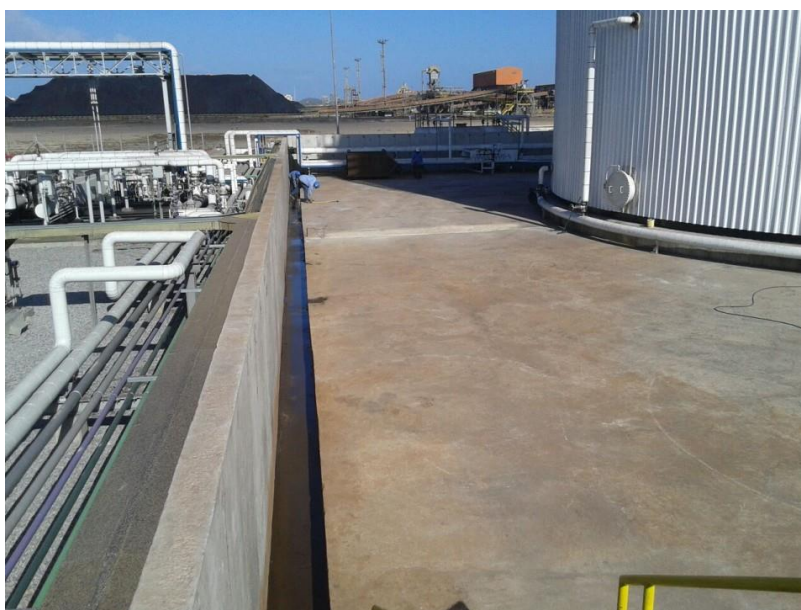
Figura 4-78: Canaleta e muro de contenção da bacia. Fonte: Alexandre Fávoro, 2020.
