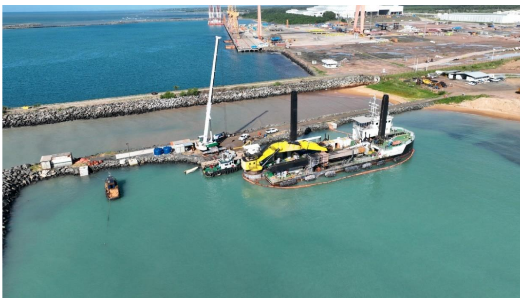
Figura 4-24: Draga backhoe atracada na Estrutura de Apoio a Dragagem. Fonte: Acervo Imetame.
