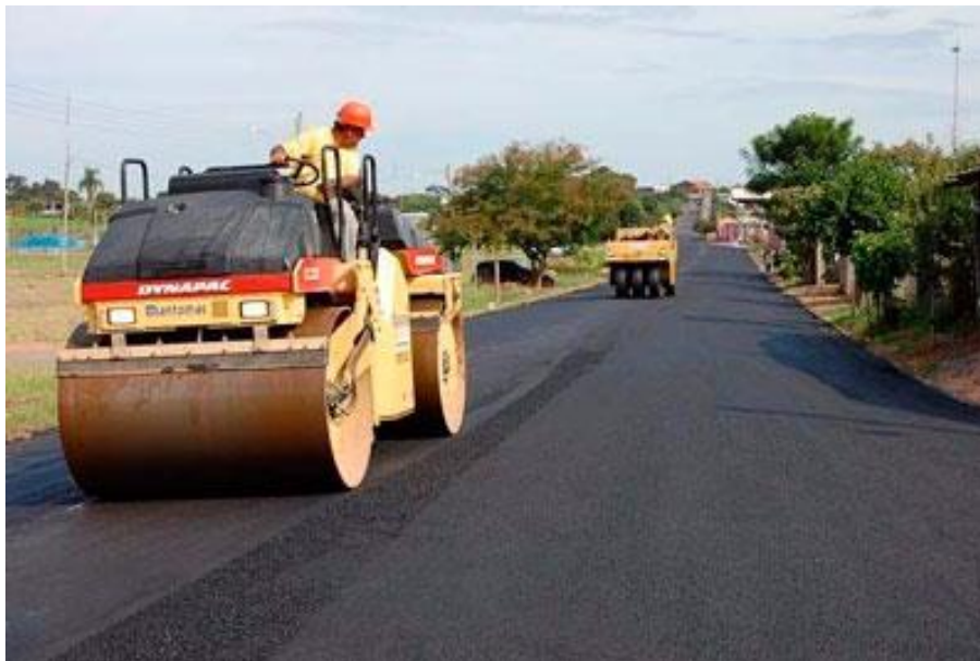
Figura 4-57: Atividades de pavimentação asfáltica com Rolo Compactador e Vibro Acabadora Asfáltica.
