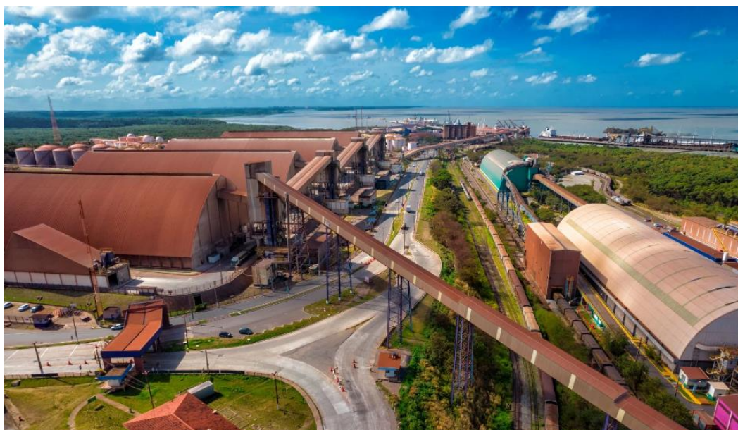
Figura 4-108: Correia transportadora de grãos enclausurada. Fonte: Divulgação/EMAP – Terminal de Grãos do Maranhão (TEGRAM), 2022.
