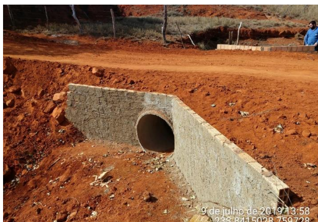
Foto 3-9: Implantação de boeiro em acesso. Fonte: Acervo Dossel, 2019.
