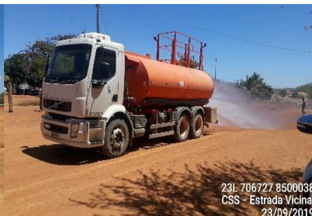
Foto 3-4: Umedecção em via de acesso não pavimentada. Fonte: Acervo Dossel, 2019.
