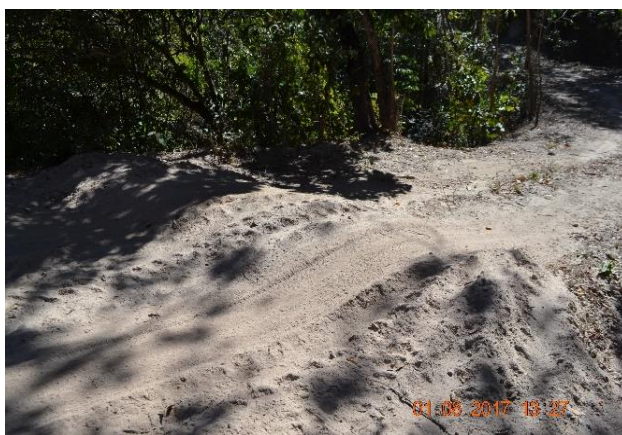
Foto 3.3-1: Exemplo de camalhão em via de acesso. Fonte: Acervo Dossel, 2017.
