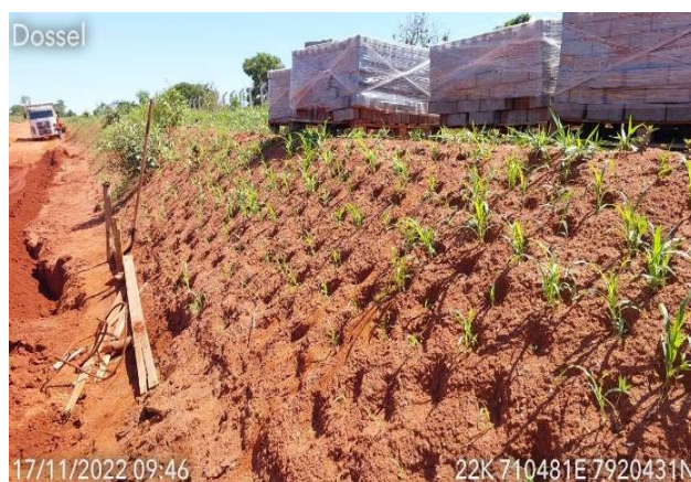
Foto 3-33: Detalhe de talude com vegetação em desenvolvimento. Fonte: Acervo Dossel, 2022.
