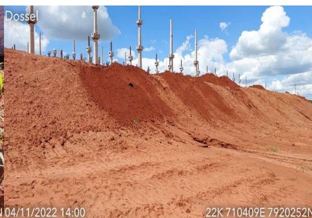
Foto 3-34: Área de talude reconformado após aplicação da primeira hidrossemeadura. Fonte: Acervo Dossel, 2022.
