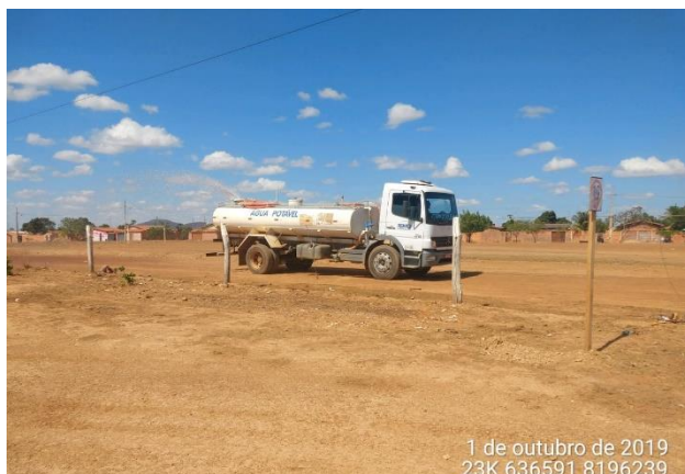
Foto 3-3: Umedecção em via de acesso não pavimentada. Fonte: Acervo Dossel, 2019.
