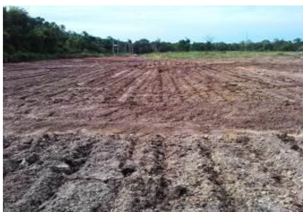
Foto 3-25: Área de canteiro de obras desmobilizado. Escarificação do solo e semeadura de capim-quicuío ( Pennisetum clandestinum ). Fonte: Acervo Dossel, 2015.
