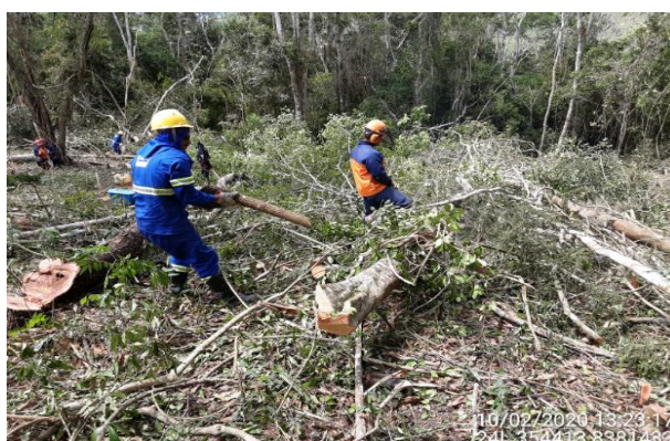
Foto 3-39: Destopamento e rebaixamento de galhada de árvore suprimida. Fonte: Acervo Dossel, 2020.
