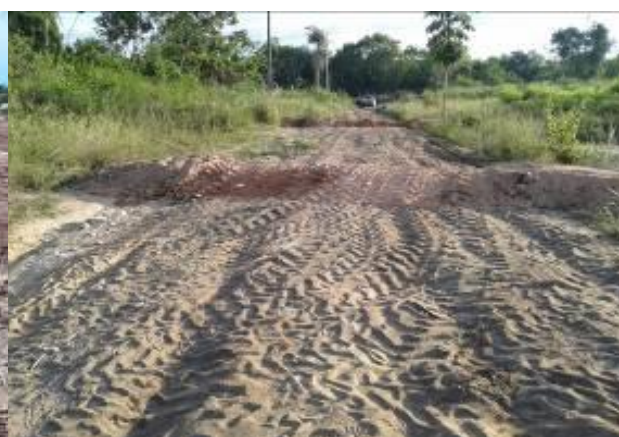
Foto 3-16: Área de canteiro de obras desmobilizado. Construção de camalhão para desvio d'água para as áreas vegetadas concluídas. Fonte: Acervo Dossel, 2015.
