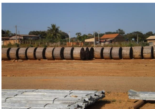
Foto 3-13: Canteiro de obras implantado em zona urbana. Fonte: Acervo Dossel, 2014.
