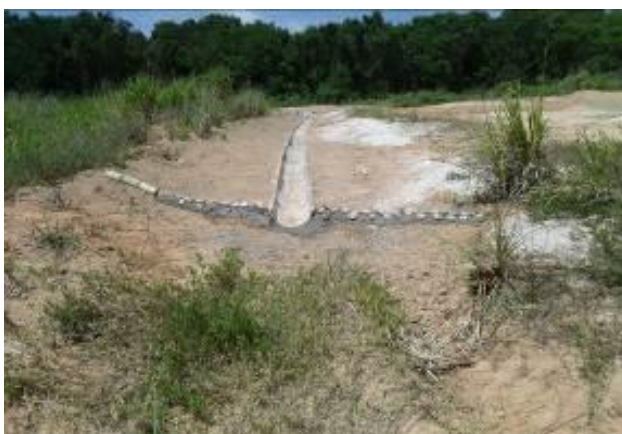
Foto 3-31: Início de sarjeta de escoamento em área de bota-fora. Fonte: Acervo Dossel, 2015.
