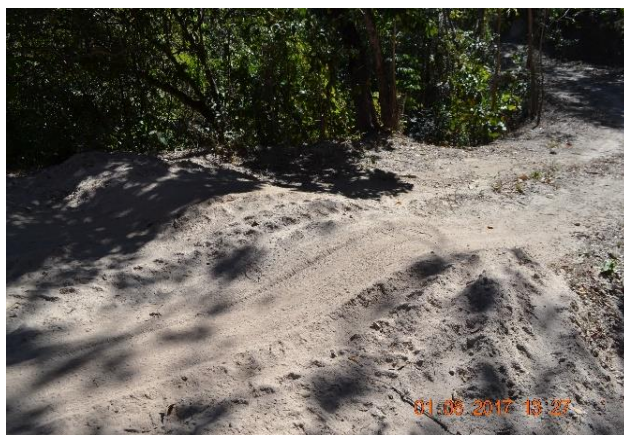
Foto 3-7: Exemplo de camalhão construído em via de acesso. Fonte: Acervo Dossel, 2017.
