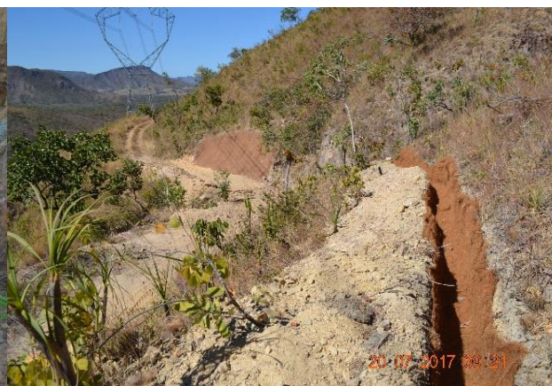
Foto 3.3-4: Exemplo de canaleta de crista com biomanta instalada em grande talude, compondo o sistema de drenagem pluvial com solos frágeis e promovendo a revegetação. Fonte: Acervo Dossel, 2017.
