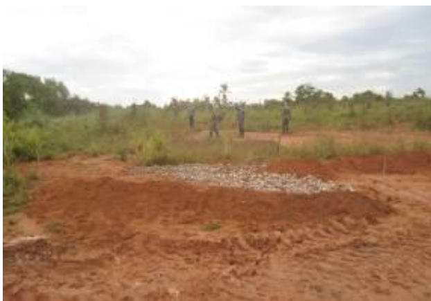
Foto 3-29: Dissipadores de energia (murundus) construídos para dividir as águas no percurso até as canaletas localizadas nas laterais do bota-fora. Fonte: Acervo Dossel, 2015.
