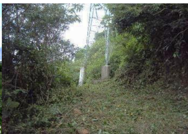
Foto 3-12: Praça de torre autoportante. Fonte: Acervo Dossel, 2020.
