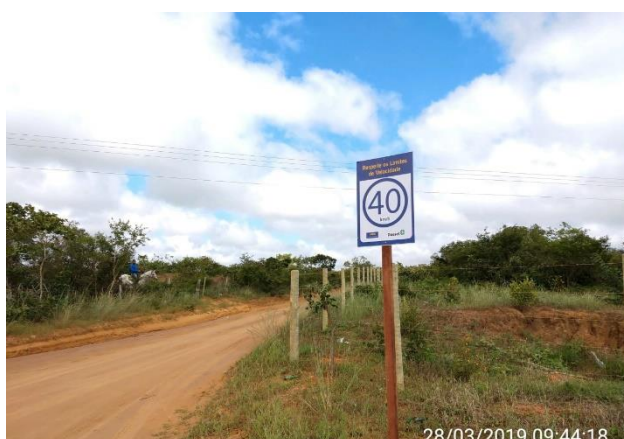
Foto 3-5: Placa de controle de velocidade em via de acesso não pavimentada. Fonte: Acervo Dossel, 2019.
