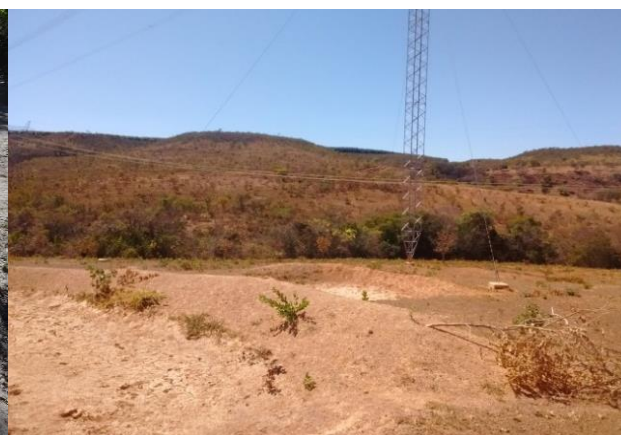
Foto 3.3-2: Exemplo de conjunto de barraginhas subsequentes, protegendo as estruturas de uma torre estaiada. Fonte: Acervo Dossel, 2016.
