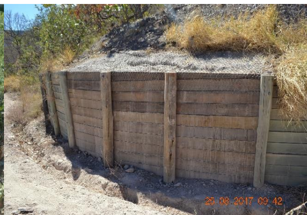
Foto 3.3-6: Exemplo de paliçada para conter desmoronamento de sedimento do talude. Fonte: Acervo Dossel, 2017.
