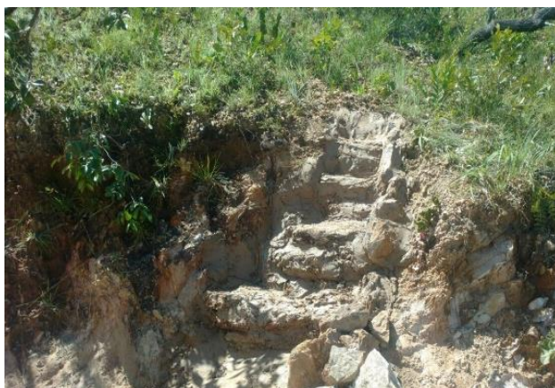
Foto 3.3-5: Exemplo de escada hidráulica construída com pedras de mão e solo-cimento. Fonte: Acervo Dossel, 2017.
