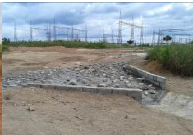
Foto 3-30: Entrada de canaleta com pedras de mão e concreto, para direcionamento do fluxo d'água em área de bota-fora. Fonte: Acervo Dossel, 2015.
