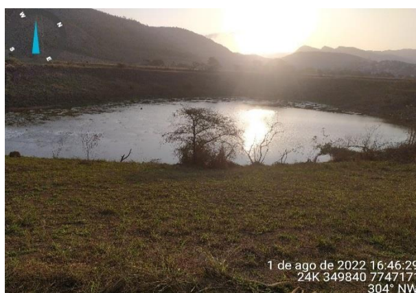
Foto 11-45: Barramento do córrego da Ribeira, próximo à estação de Viana. Data: 01/08/2022. Coordenadas UTM: 24K 349840 E 7747171 N.
