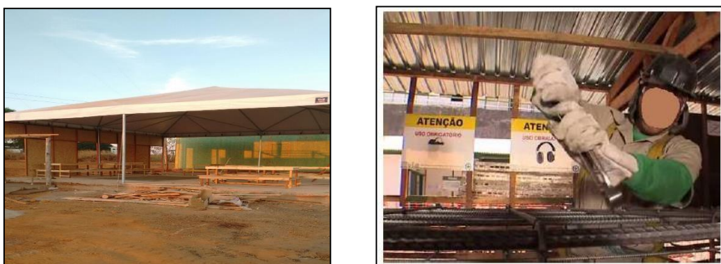
Figura 12: Exemplo de área de carpintaria e central de armação.
