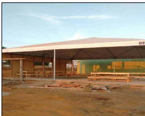
Figura 12: Exemplo de área de carpintaria e central de armação.
