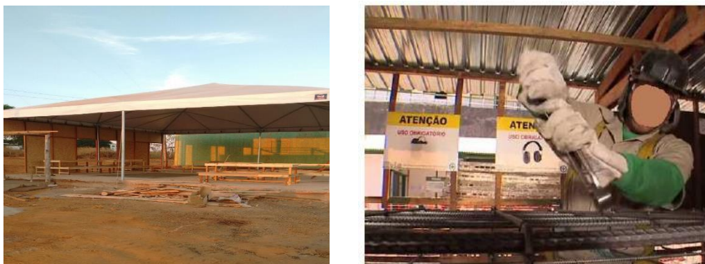
Figura 8 - Exemplo de área de carpintaria e central de armação.
