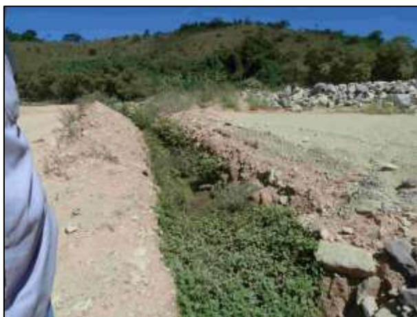
Figura 1.10.2.3-6: Aspecto do canal construído sobre as bancadas.
