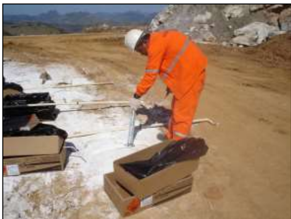
Figura 1.10.2.1.2-3:Carregamento de furos com explosivo.
