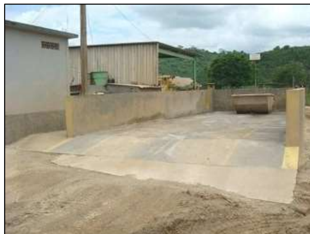
Figura 1.10.2.6.2-1: Rampa de lavagem de máquinas e equipamentos.
