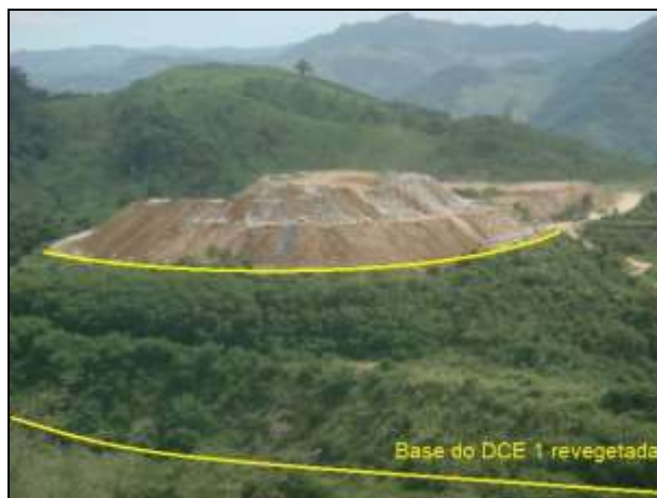
Figuras 1.10.2.2-1: Vista do DCE 1 onde se notam os taludes inferiores revegetados e a porção superior com solo exposto.
