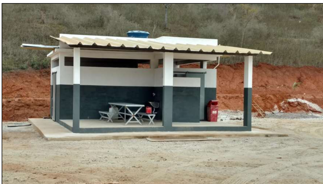
Figura 1.10.2.6.3-1: Unidade de apoio aos trabalhadores da cava.
