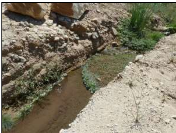
Figura 1.10.2.3-7: Aspecto do canal construído sobre as bancadas.
