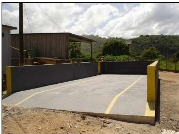
Figura 1.10.2.6.2-1: Rampa de lavagem de máquinas e equipamentos.
