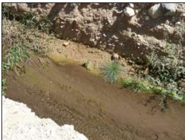
Figura 1.10.2.3-8: Aspecto do canal construído sobre as bancadas
