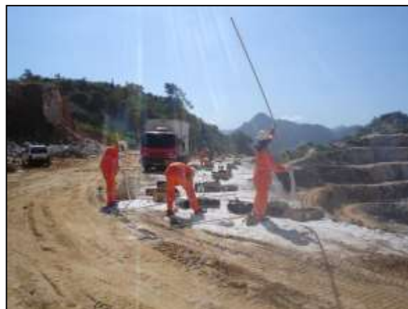
Figura 1.10.2.1.2-3:Carregamento de furos com explosivo.
