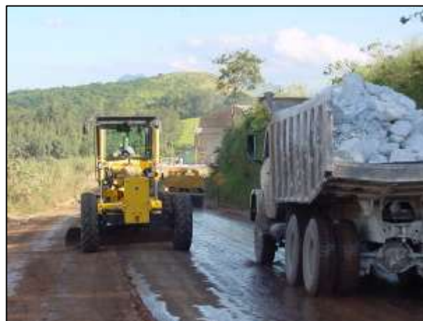
Figura 1.10.2.1.3-2: Transporte de minério, trabalho de manutenção da via e aspersão de água para mitigar poeira
