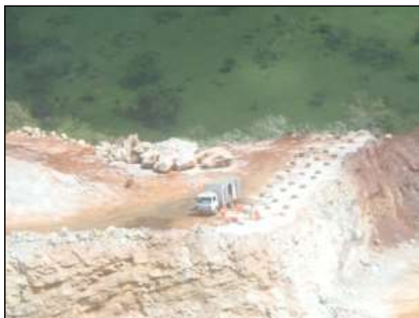
Figura 1.10.2.1.2-4: Bancada carregada com explosivos.
