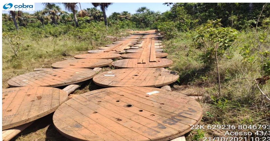
Figura 12: Modelo de construção de estivas com uso de tampas de bobinas para acessar as torres em áreas alagáveis.
