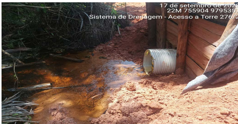
Figura 09: Modelo de construção de rede de drenagem (Bueiro).
