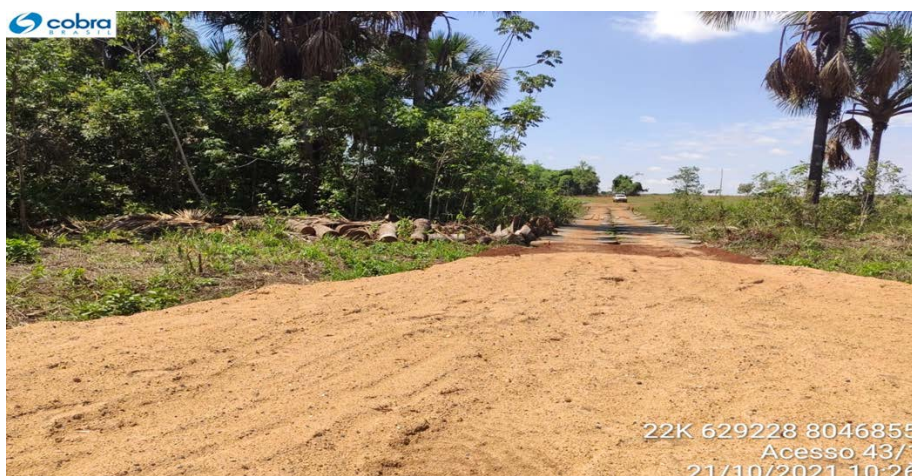
Figura 11: Modelo de construção de estivas com uso de tampas de bobinas para acessar as torres em áreas alagáveis.
