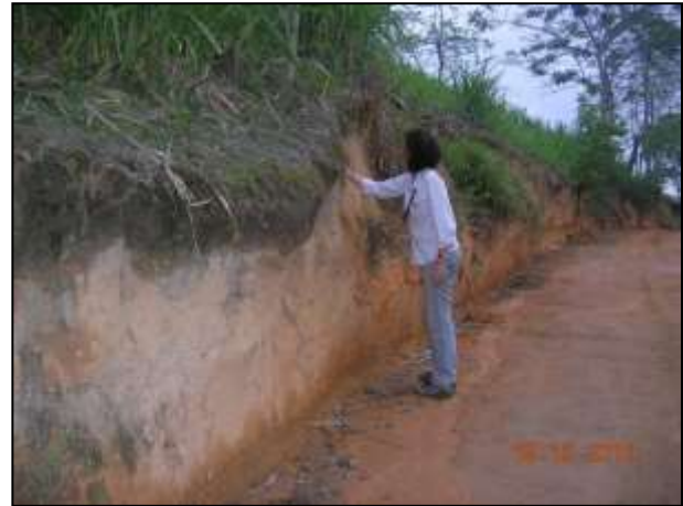
Figura 2.4.3.2-2: Barranco formado por corte de estrada utilizado para observação de subsuperfície.
