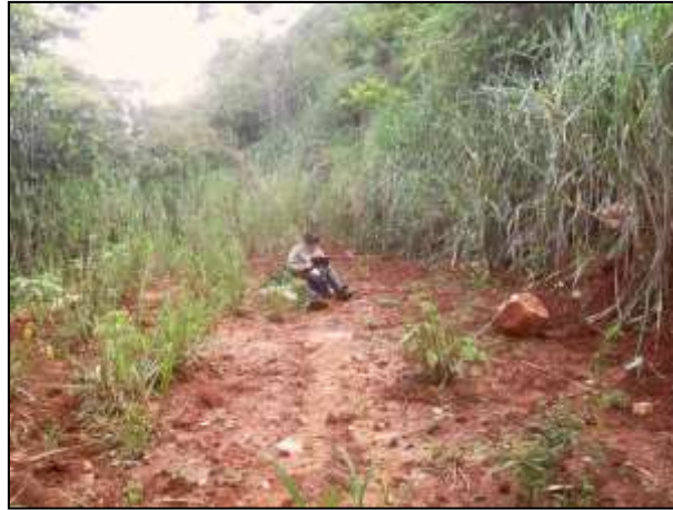
Figura 2.4.2.5.1-19: Estrada abandonada dentro da área de ampliação da mina.
