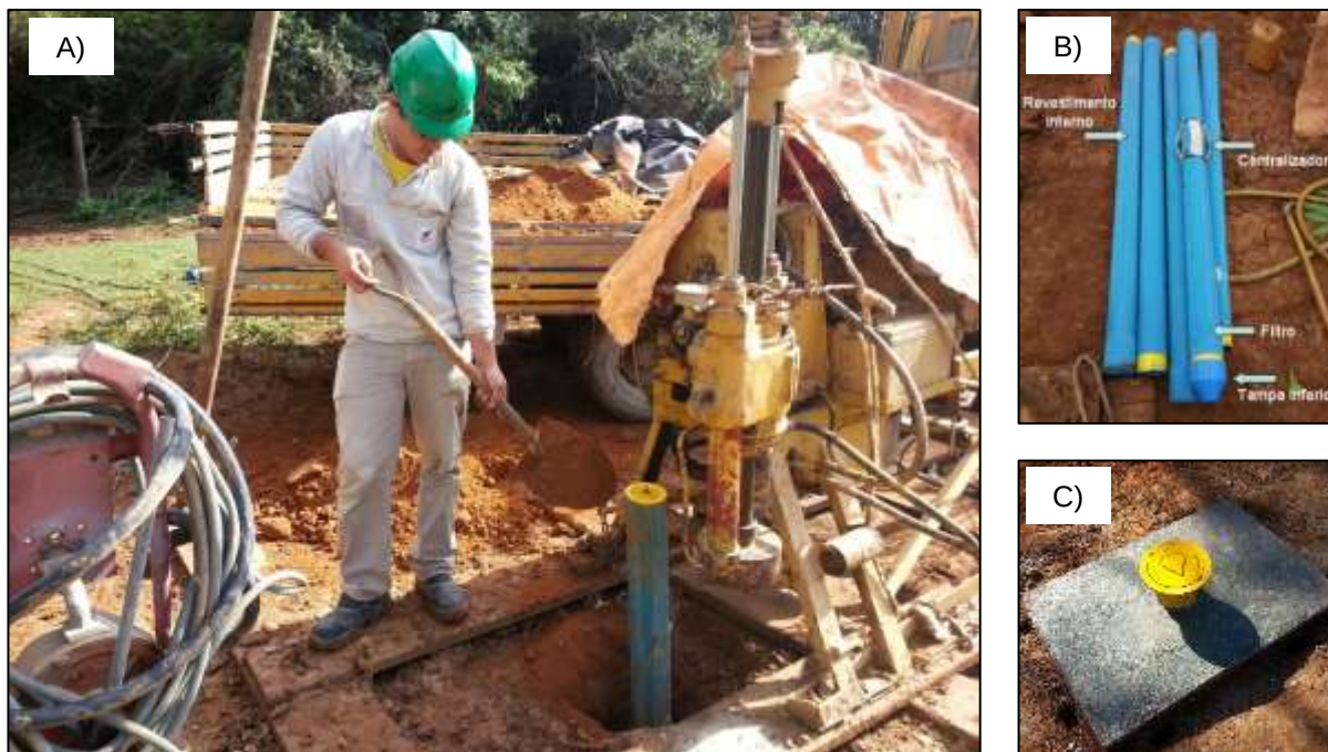
Figura 2.2.5-4: Etapas da perfuração de um dos três poços de monitoramento construídos. Todos os três poços foram construídos em conformidade com as normas técnicas vigentes. A) Perfuração do poço de monitoramento; B) Material de revestimento utilizado, e; C) Poço de monitoramento construído.
