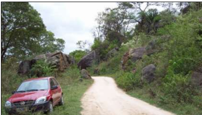
Figura 2.2.1-5: Local da falha contracional. Notar blocos de rocha tombados em estrada devido à atuação de processos geodinâmicos em maciço rochoso fraturado (Ponto N14).
