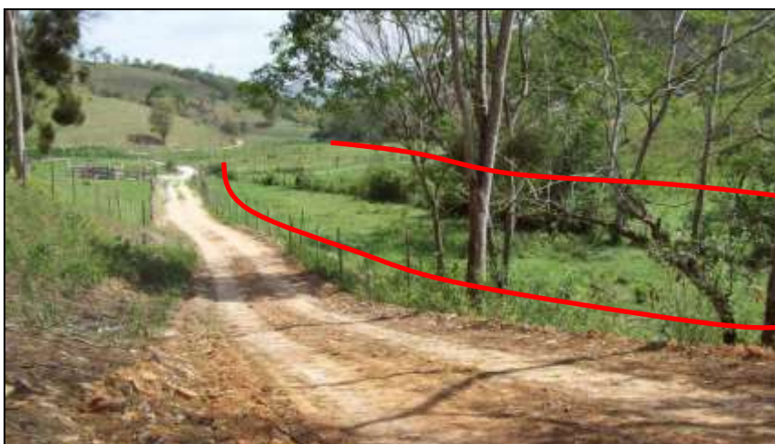
Figura 2.2.1-6: Local da falha contracional. Notar área mais abatida à direita, devido à maior dissecação do relevo em função da falha (Ponto N4).
