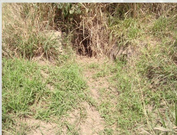
Figura 11-24: Leito seco do Córrego 4 na sua passagem sob a ES-320.
