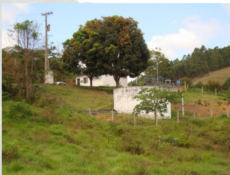
Figura 11-148: Vista da ETA de Santa Luzia de Mantenópolis.
