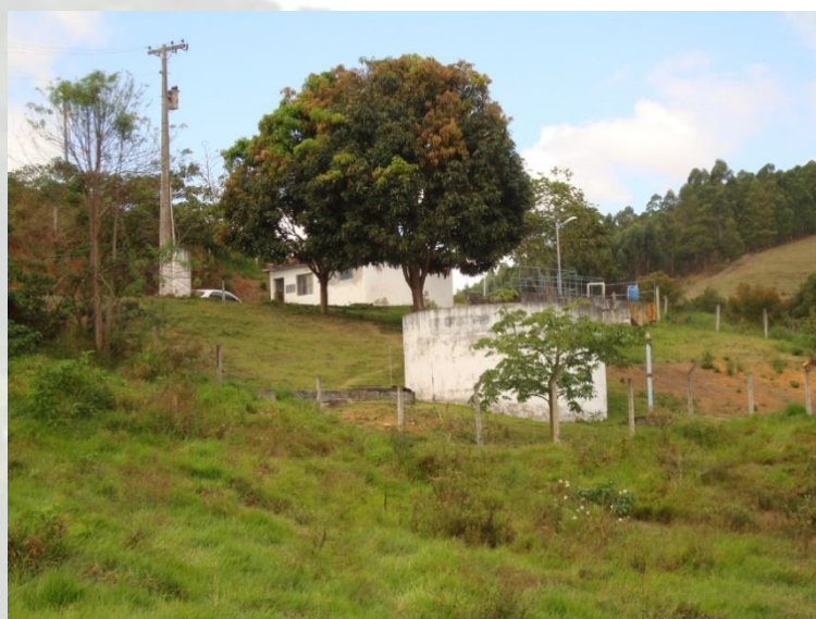
Figura 11-148: Vista da ETA de Santa Luzia de Mantenópolis.
