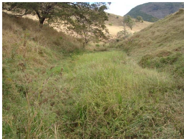
Figura 11-35: Leito do córrego 17 tomado por gramíneas a montante da sua interceptação com a ES-320.
