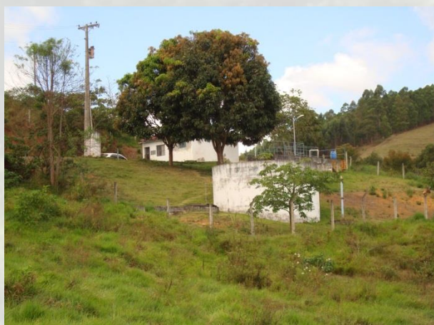
Figura 11-28: Vista da Estação de Tratamento de Água de Santa Luzia de Mantenópolis
