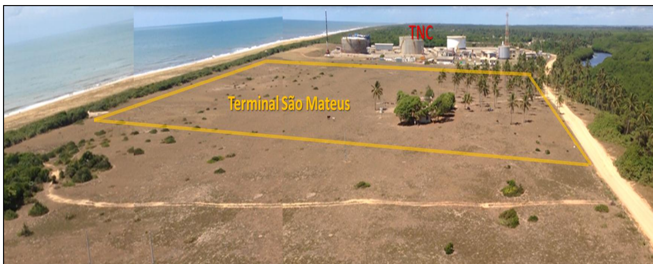
Figura 3-4: Mosaico fotográfico indicando a localização do Terminal São Mateus. Ao fundo o Terminal Norte Capixaba – TNC.
