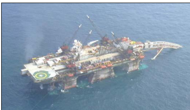
Figura 3-17: Embarcação de lançamento Acergy Piper. Fonte: Petrobras.
