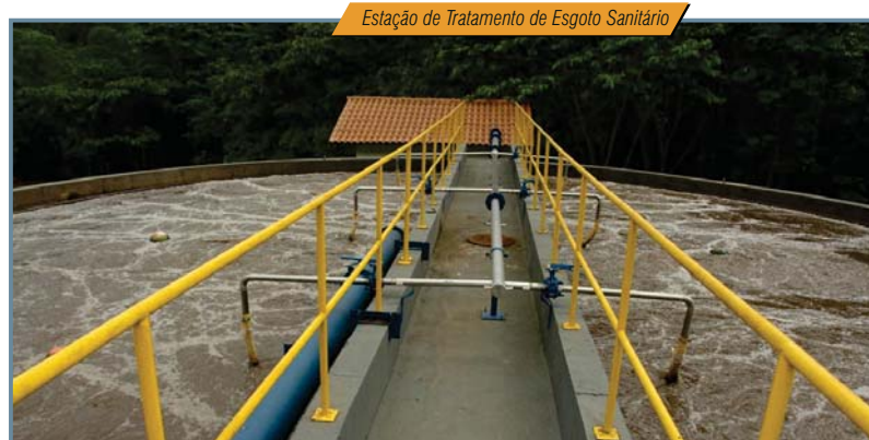
Estação de Tratamento de Esgoto Sanitário
