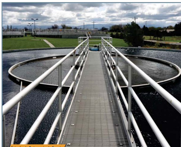
Estação de Tratamento de Esgoto
