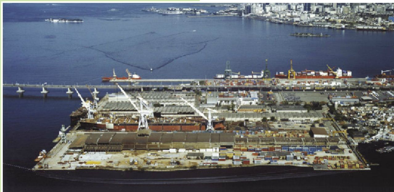
Figura 06 – Vista aérea da base de apoio logístico, Briclog. Fonte: www.briclog.com.br
