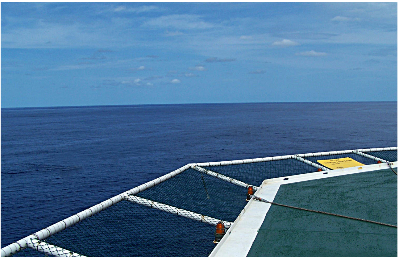
Figura 32 – Vista de uma plataforma. Fonte: AECOM
