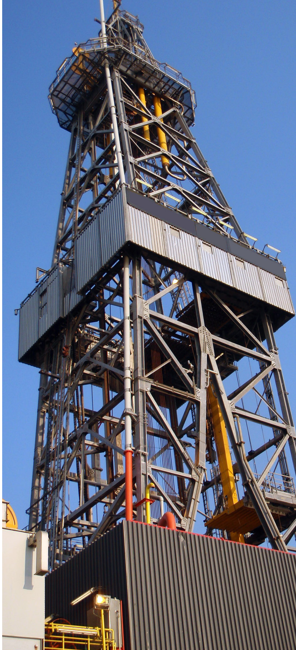
Figura 33 - Torre de perfuração. Fonte: AECOM
