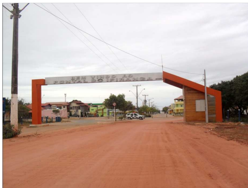
Figura 97- Portal de entrada ao balneário de Pontal do Ipiranga
