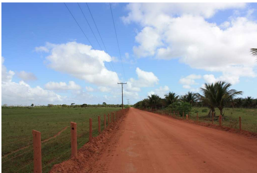
Figura 36 - Estrada vicinal para o acesso à área do empreendimento.
