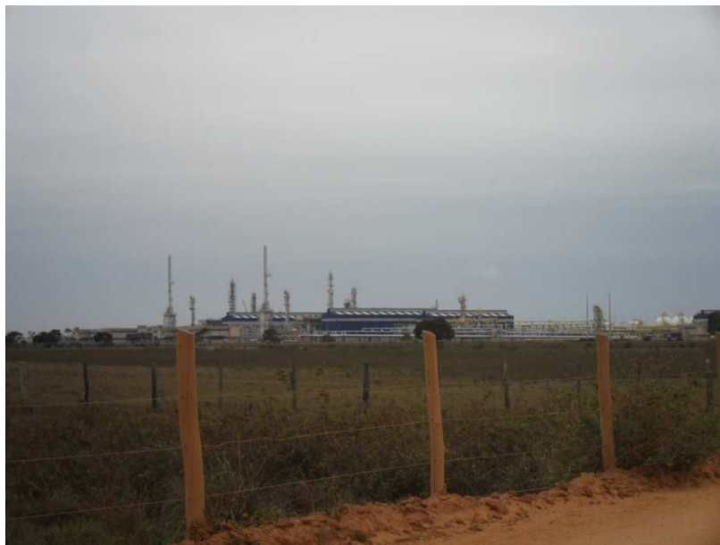
Figura 95 - UTG Cacimbas – Estrada que dá acesso a Pontal
