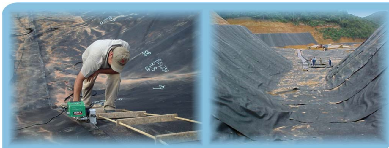
Figura 3: Sistema de Impermeabilização. Colocação da manta de Polietileno de Alta densidade PEAD.
