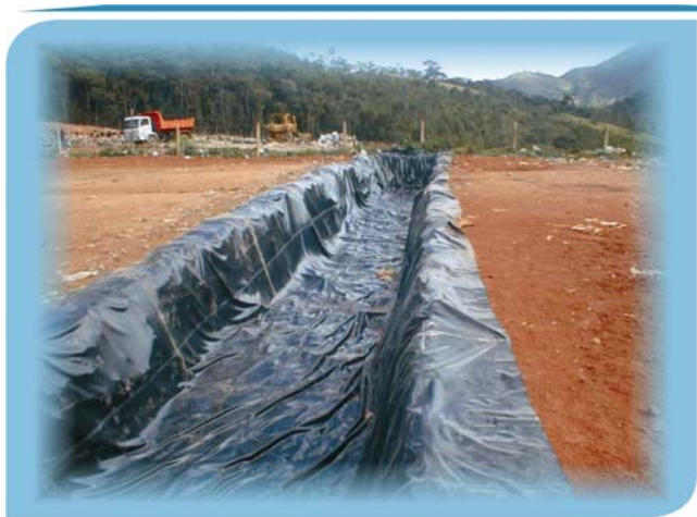
Figura 4: Sistema de impermeabilização nos canais de drenagem.
