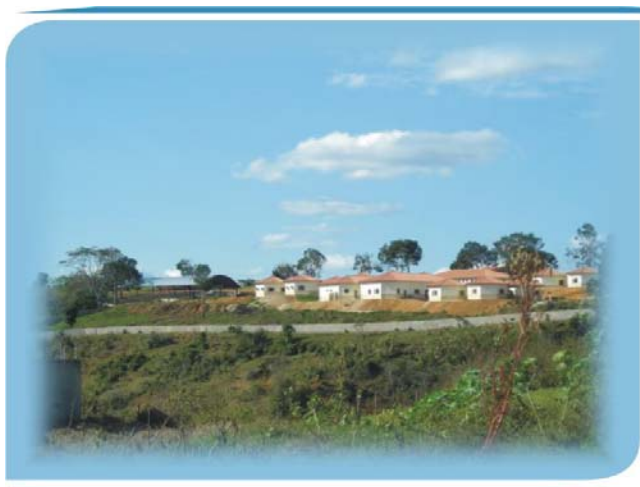
Figura 27: Escola em construção no bairro.
