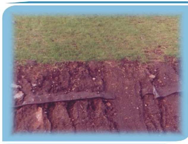
Figura 9 - Detalhe da cobertura final prevista para o encerramento da CTR Santa Rosa.
