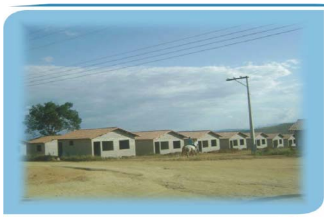
Figura 26: Casas populares no bairro, em construção.
