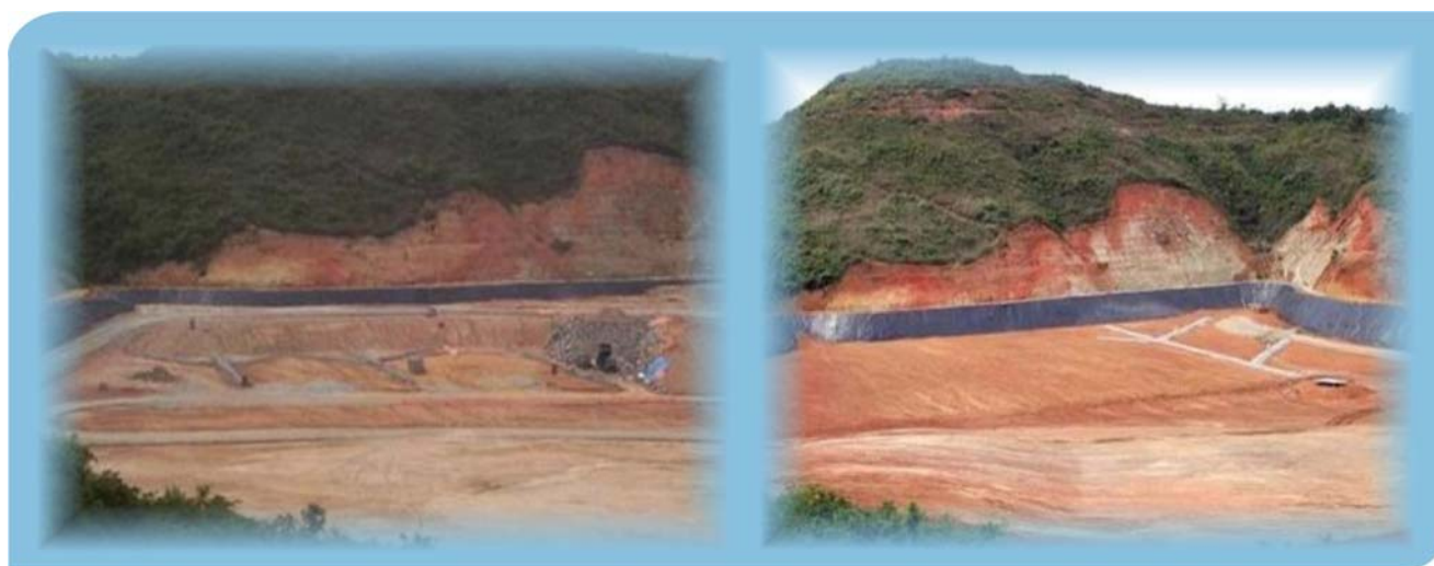
Figuras 7: Drenagem de percolados na base em empreendimentos semelhantes ao CTR Colatina.
