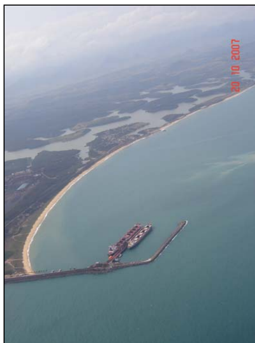
Figura 1.2-1: Vista aérea do Terminal Portuário de Ubu.
