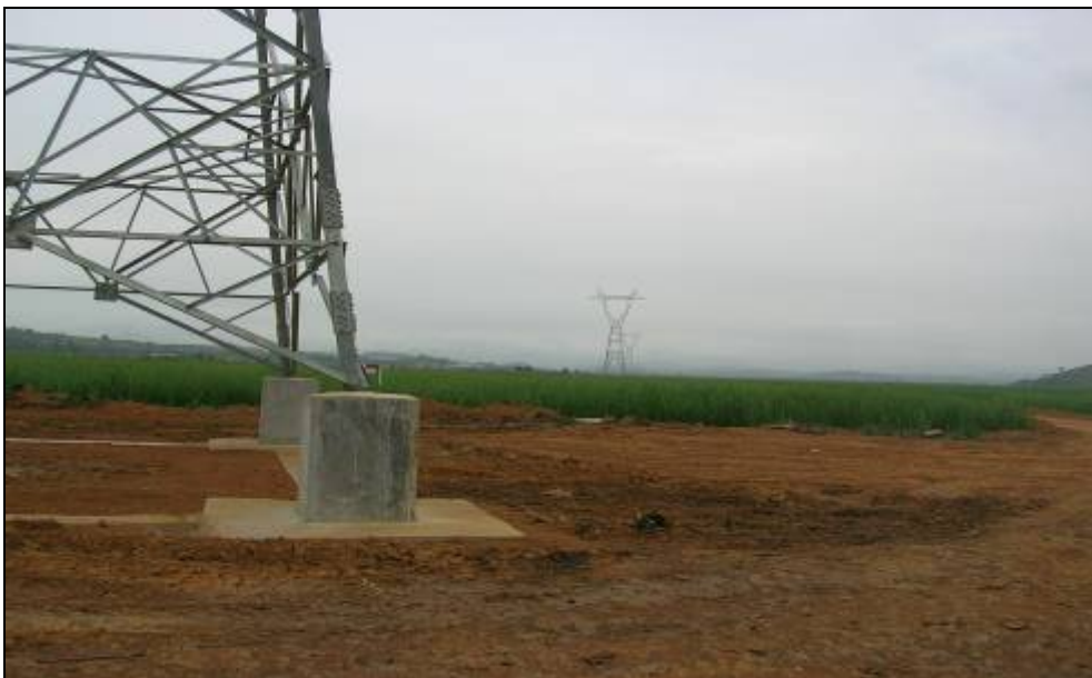
Figura 3.8.4.9-9: Detalhe da vista da área do empreendimento. Observar aterro para implantação da torre e via de acesso referentes a LT Ouro Preto - Vitória.
