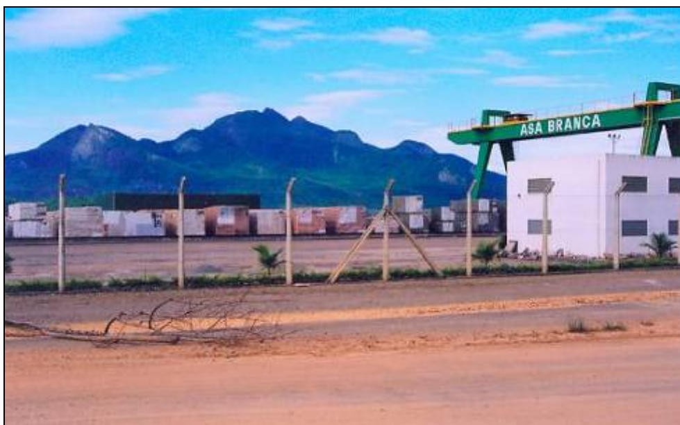
Figura 3.8.2-4: Asa Branca - Rodovia do Contorno no entorno do Pólo Industrial Jacuhy - Serra. Fonte: CEPEMAR (2005).
