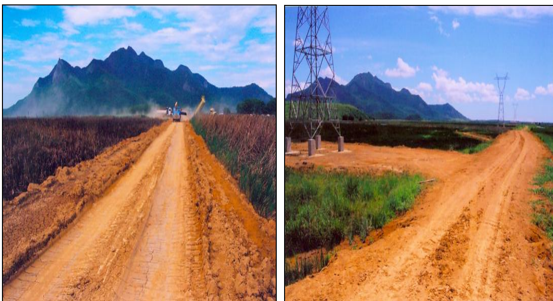
Figuras 3.7.1-4 e 3.7.1-5: Aterro na imensa planície alagada para a construção de novas estradas de acesso para as futuras torres da Linha de Transmissão de Furnas (Ouro Preto – Vitória). Fotos © J. L. Gasparini.
