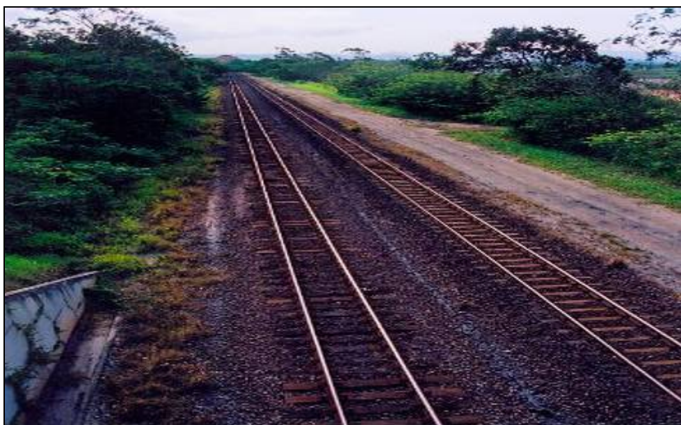
Figura 3.3-2: Vista da Estrada de Ferro Vitória-minas no entorno do Polo Industrial Jacuhy, em área de ocorrência do Grupo Barreiras.
