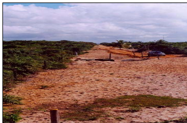
Figura 2-5 – Ponto de chegada dos dutos na praia de Cacimbas em Linhares-ES e a faixa de servidão do gasoduto Peroá-Congoá a partir da praia de Cacimbas, onde será instalado o gasoduto de Golfinho
