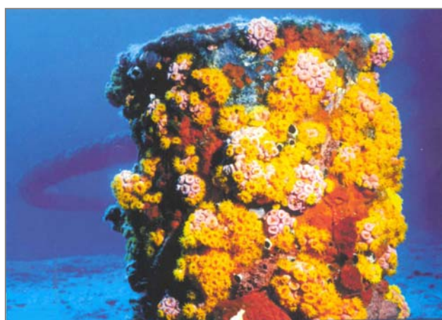
Figura 4-14 – Processo de incrustação biológica em estruturas rígidas componentes do sistema de produção de petróleo no mar.
