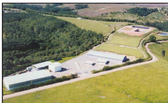
Figura 2-21 - Vista aérea da empresa Vitória Ambiental.
