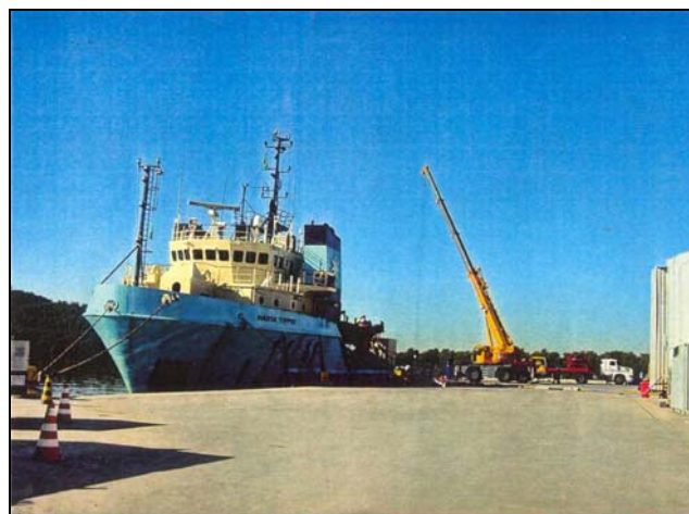
Figura 2-15 - Cais para rebocadores do Terminal da CPVV
