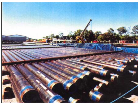
Figura 2-18 - Parque de tubos no CPVV.
