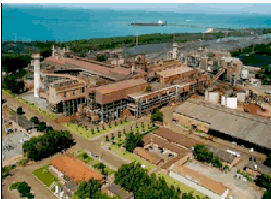
Figura 1.1-5: Vista Geral da Planta de Pelotização em Ponta Ubu.
