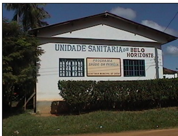
Figura 3.3-20: Unidade Sanitária de Belo Horizonte.
