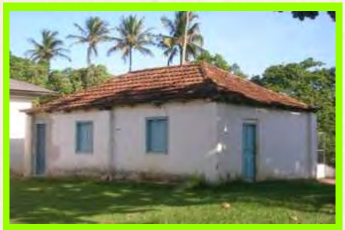
Fig. 36: Casa Canônica em Belo Horizonte.
