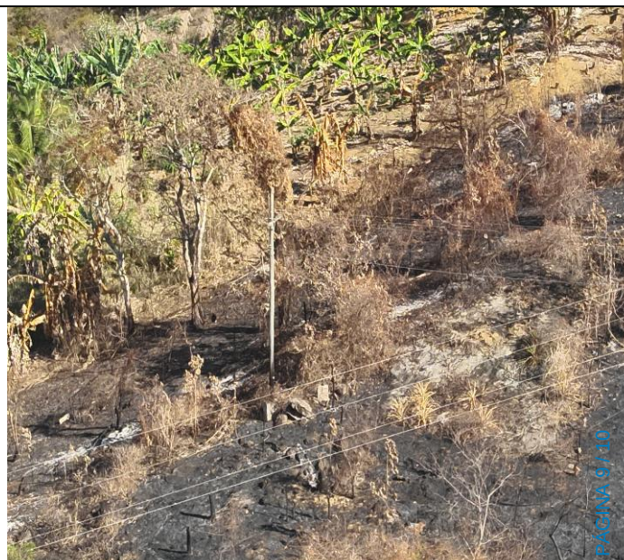
Vista da rede elétrica da provável origem do sinistro
