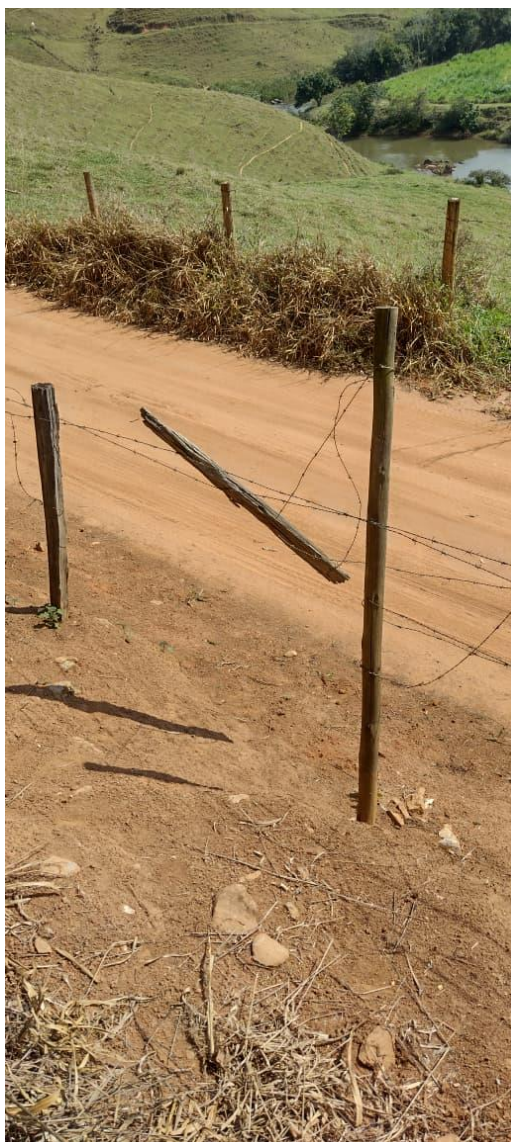
Foto 01 – Vista parcial da queimada e trecho da cerca violado.
