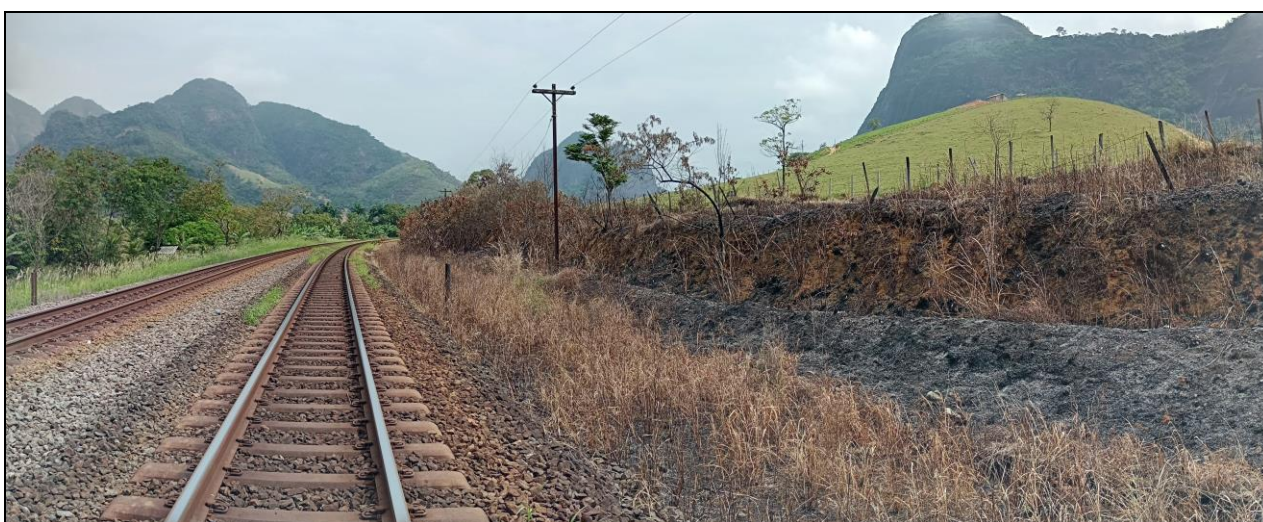
Foto 6: A despeito de a linha férrea demarcar o limite territorial da UC, é relevante enfatizar que a vegetação nativa, objeto primordial de proteção desta Unidade, permanece intacta. Esta se situa a aproximadamente 500 metros da zona incendiada e pode ser visualizada na elevação à direita desta fotografia.
