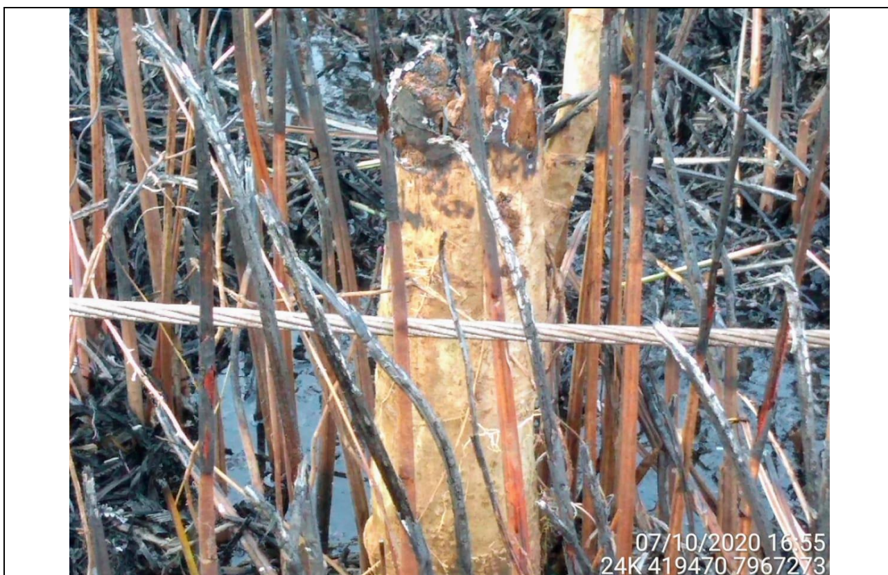
Figura 11: Cabo de alta tensão caído sobre a vegetação do alagado, no local onde se iniciaram as chamas.
