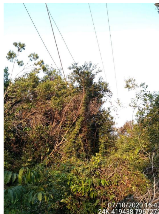
Figuras 13 e 14: Situação da rede de alta tensão que passa sobre a região alagável do córrego Santa Helena, próximo ao local onde se iniciou o foco de incêndio. A grande quantidade de vegetação nos cabos evidencia falta de poda preventiva, por parte da empresa de energia.
