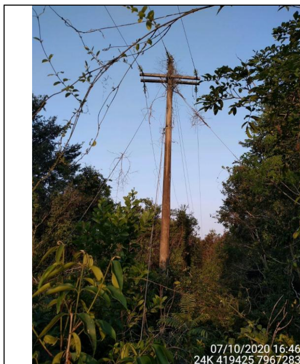
Figuras 13 e 14: Situação da rede de alta tensão que passa sobre a região alagável do córrego Santa Helena, próximo ao local onde se iniciou o foco de incêndio. A grande quantidade de vegetação nos cabos evidencia falta de poda preventiva, por parte da empresa de energia.
