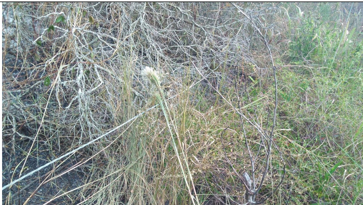
Figura 13: Fio da rede de transmissão de energia elétrica solto sobre a vegetação.
