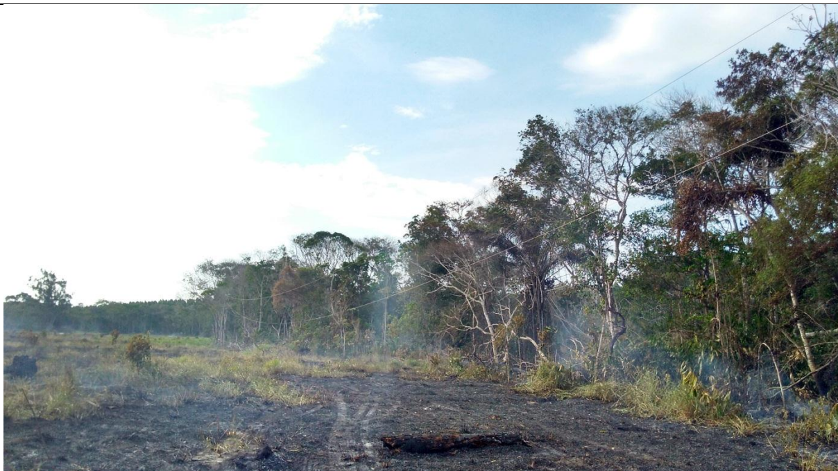
Figura 17: rede de transmissão de energia elétrica com fiação extremamente rebaixada.
