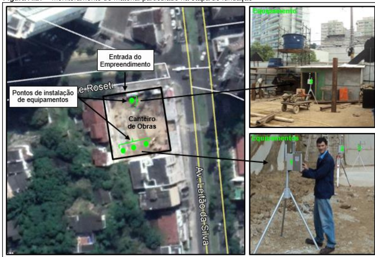
Figura A.27 – Monitoramento de material particulado na etapa de fundação
