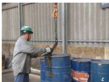
Figura 17: Içamento de tambores com caminhão munck (garra prática)
