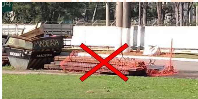
Figura 13: exemplo de obstrução do acesso a caçamba – PROIBIDO
