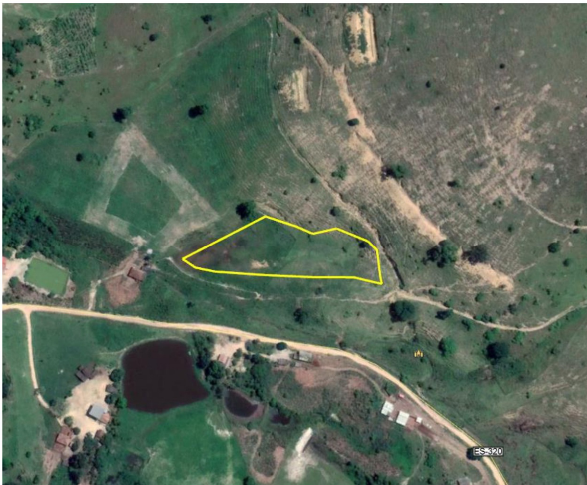
Figura 2-73 - Vista superior do Bota-Fora BF-13
