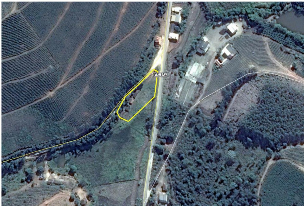
Figura 2-70 - Vista superior do Bota-Fora BF-10
