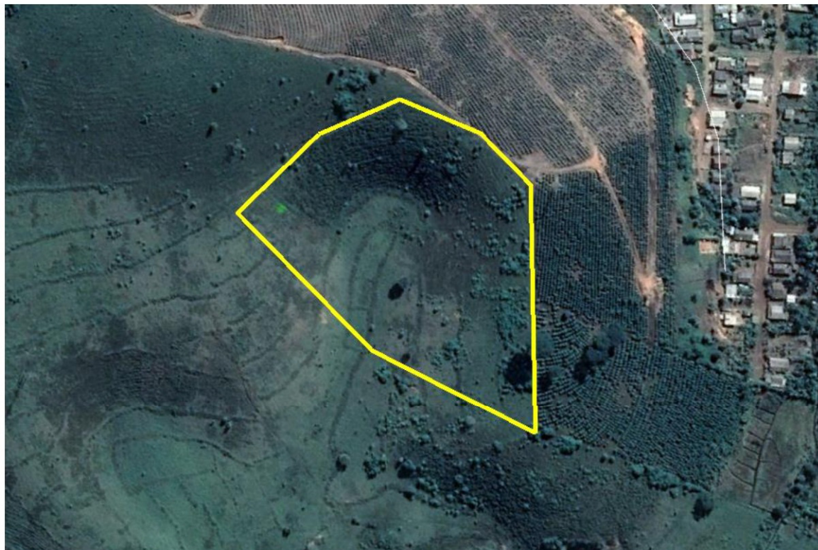
Figura 2-64 - Vista superior do Bota-Fora BF-01
