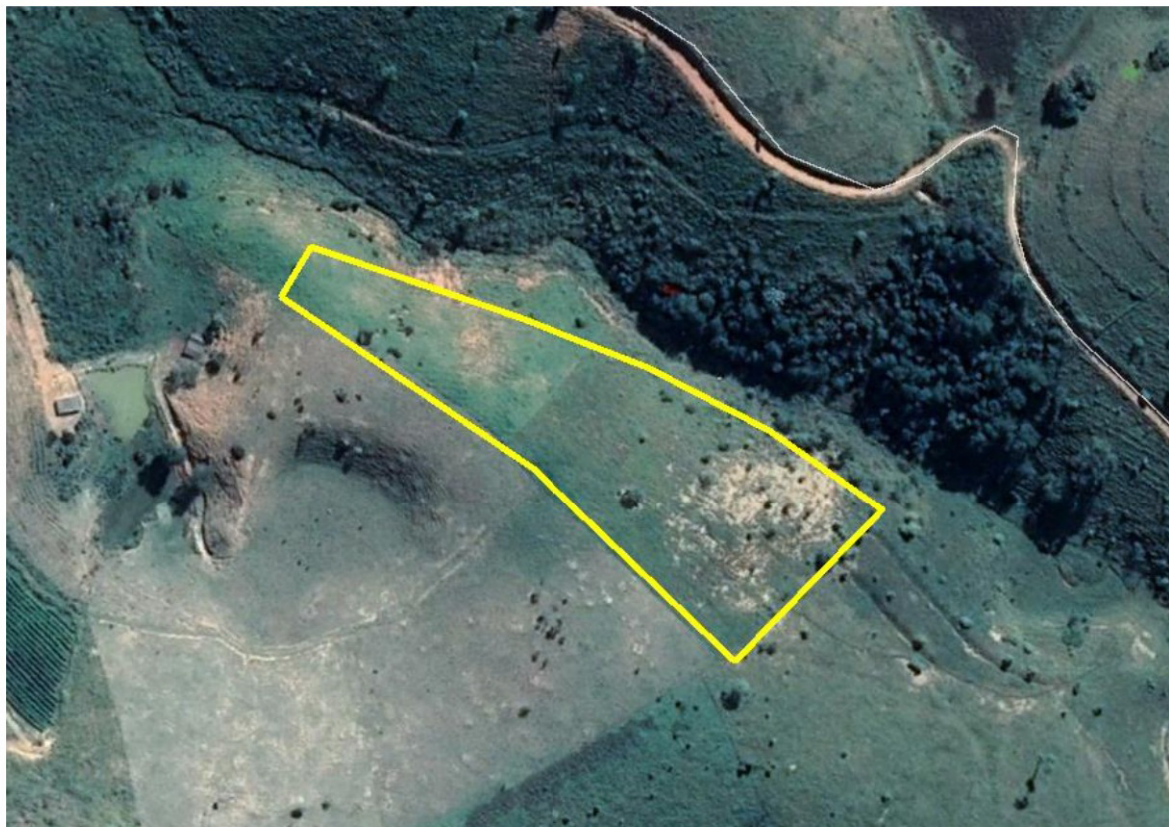
Figura 2-71 - Vista superior do Bota-Fora BF-11
