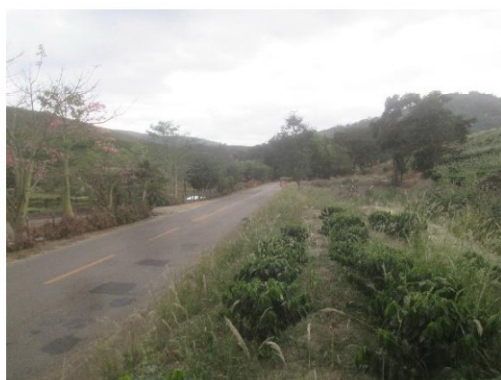
Imagem 7.1.1-6 – Tradagem 02 escavada até 80 cm de profundidade. Extensão do ponto escavado, sentido sul.
