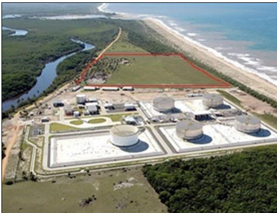
Figura 2.4-1: Vista geral da área da LiquiPort (contorno vermelho) e TNC a sul. Fonte: Prefeitura de São Mateus.
