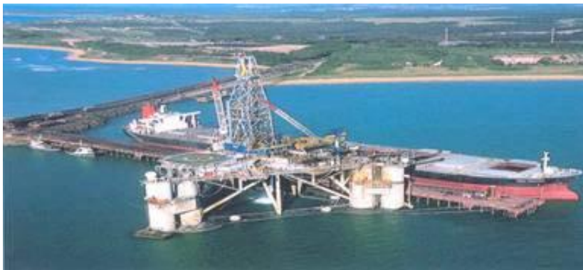
Figura 4.2-5: Terminal marítimo da Samarco em Ubu, Anchieta.
