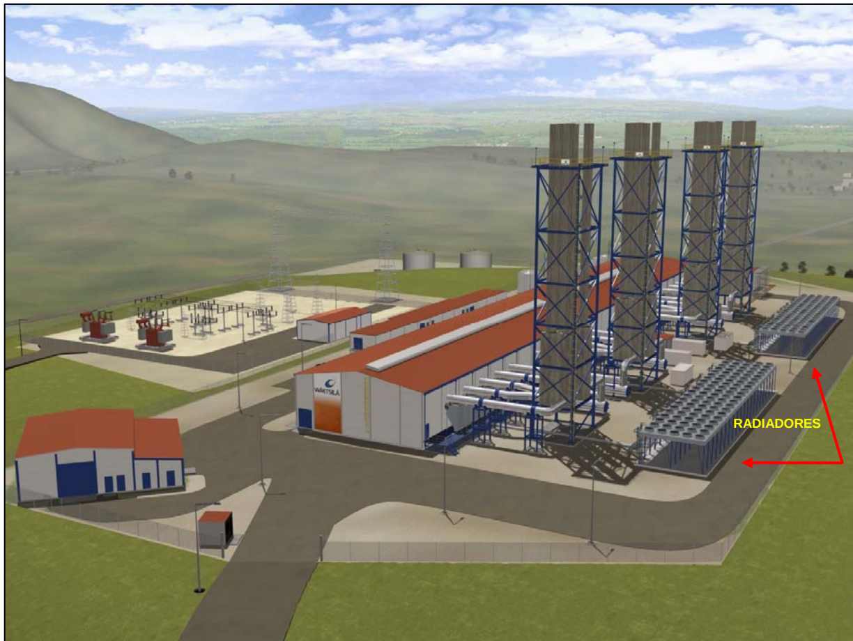
Figura 2.2.2-2: Vista geral da planta - radiadores.
