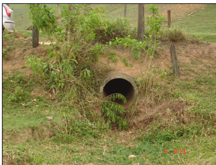
Figura 4.1.4.1-4: Dreno construído para escoamento das águas da lagoa.
