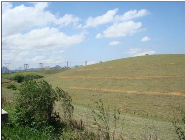
Figuras 4.1.5.1-16 e 4.1.5.1-17: Abertura de estradas e linhas de terraceamento com boa estabilidade de taludes.
