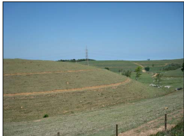
Figuras 4.1.5.1-16 e 4.1.5.1-17: Abertura de estradas e linhas de terraceamento com boa estabilidade de taludes.
