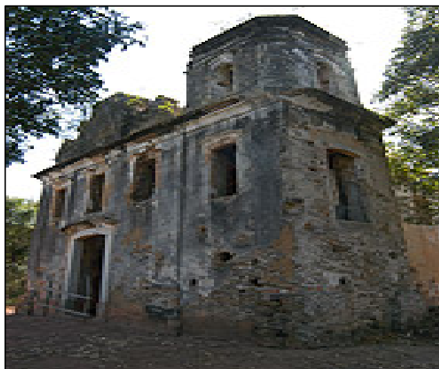
Figura 4.3.1.5-7: Igreja Nossa Senhora de Belém. Fonte: PMV
