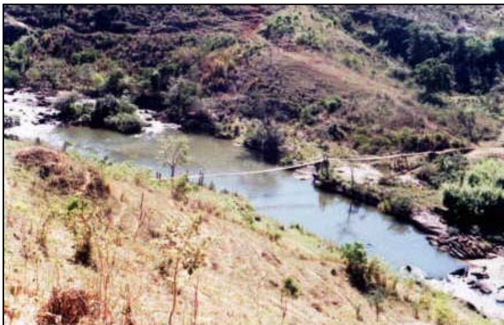
Figura 4.2.1.7 - Aspecto geral do ponto 04 no rio Braço Norte Direito e de seu entorno, à montante da área do alagamento da Barragem de Geração da PCH.
