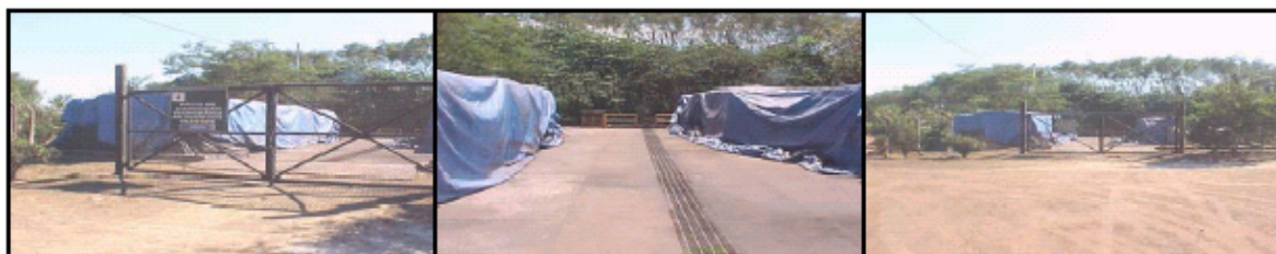
Figura 1.6.1.1-3: Vistas da Entrada e do Interior do Depósito de Resíduos de Oleosos.
