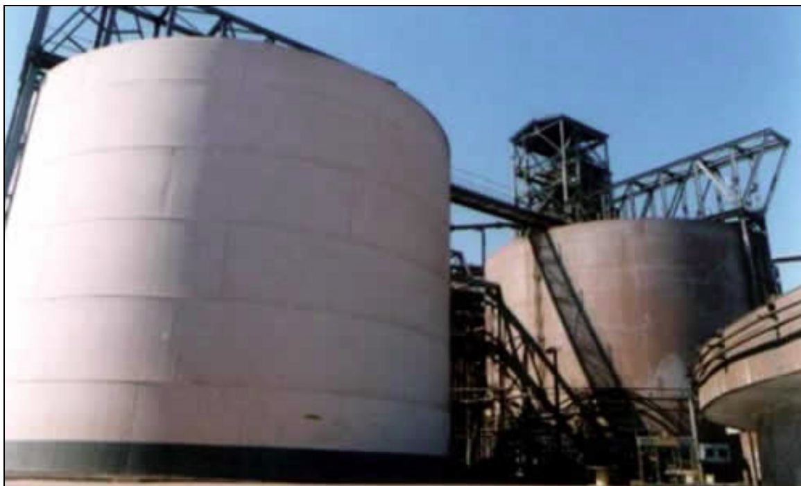
Figura 1.1.6.1-5: Vista dos Tanques Homogeneizadores
