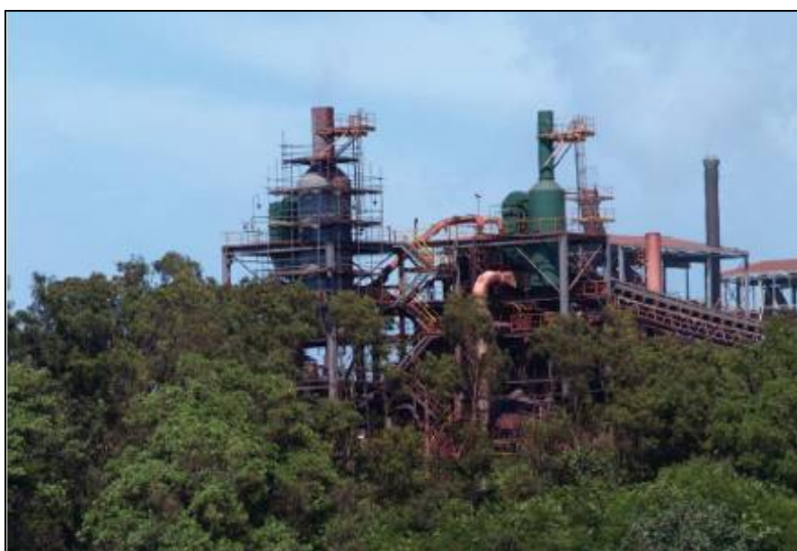
Figura 1.1.6.1-13: Vista das Estações e Peneiramento.
