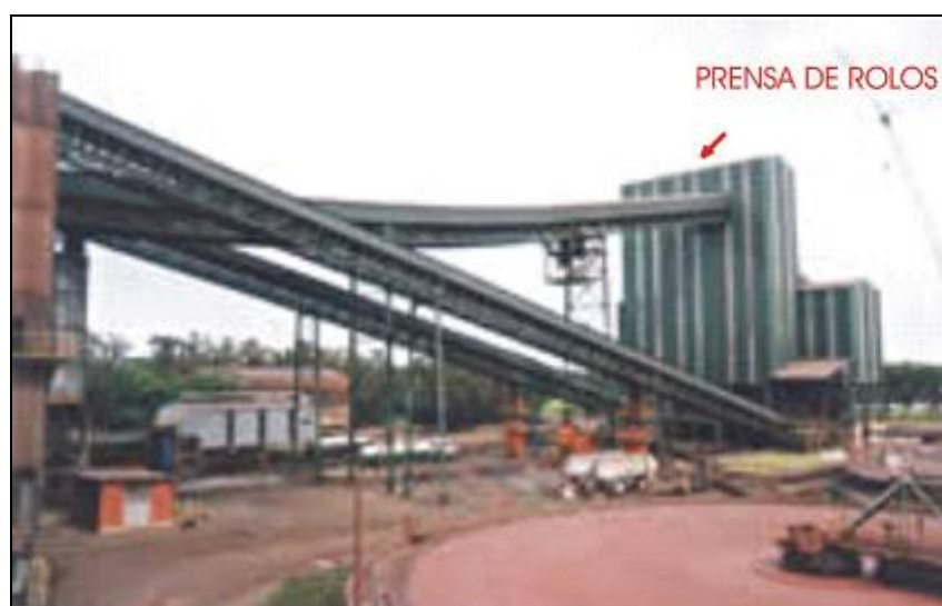
Figura 1.1.6.1-7: Vista da Prensa de Rolos (Roller Press)
