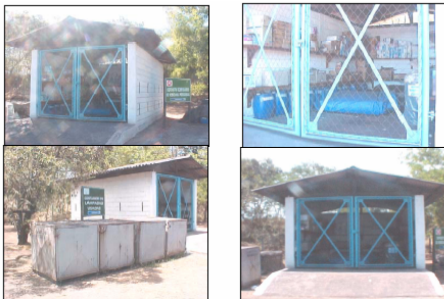
Figuras 1.6.1.1-6: Vistas Externa e Interna da Área do Depósito de Resíduos Perigosos.
