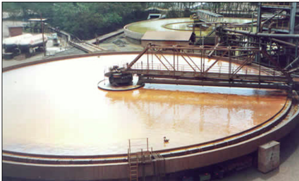
Figura 1.1.6.1-3: Vista dos Espessadores
