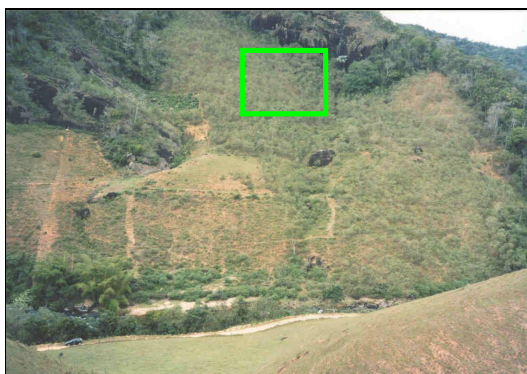
Figura 4.2.1.5.3 - Local da Chaminé de equilíbrio.
