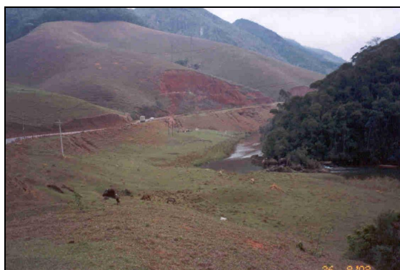
Figura 4.1.3.2.5 - Escorregamento à beira da rodovia ES-355.
