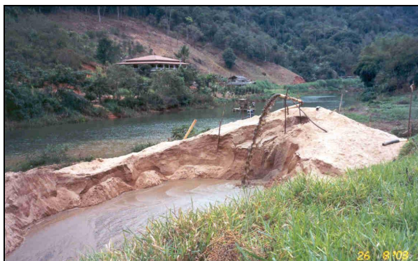
Figura 4.1.4.2.3 - Extração de areia no rio Santa Maria, no remanso da UH Suíça.
