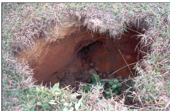
Figura 4.1.3.2.3 - Evolução do processo erosivo. Formação de “sumidouro” nos terrenos.
