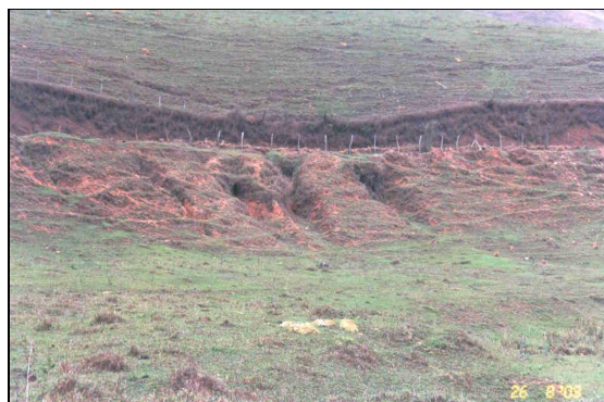
Figura 4.1.3.2.4 - Ravinas e vossorocas ao lado da ES-355, formadas pela concentração de águas que são drenadas da encosta acima.
