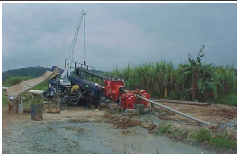
Foto 2.24 – Exemplo de equipamento de Furo Direcional.
