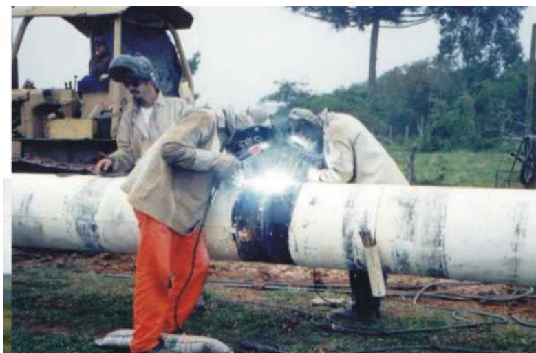
Foto 2.17 – Exemplo de solda Double Joint.
