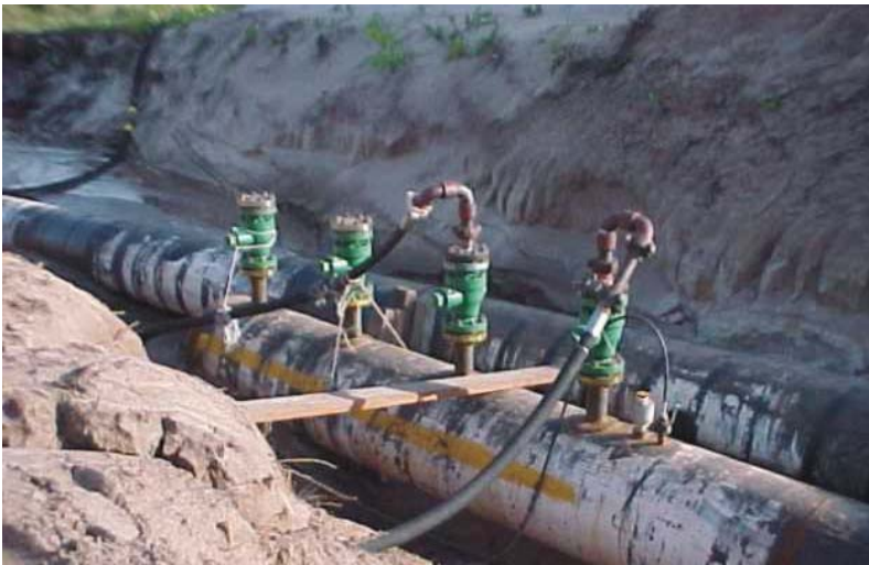
Foto 2.21 – Exemplo de Teste Hidrostático.
