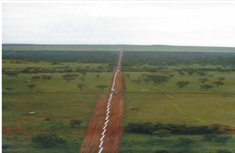
Foto 2.15 – Exemplo de desfile da tubulação.
