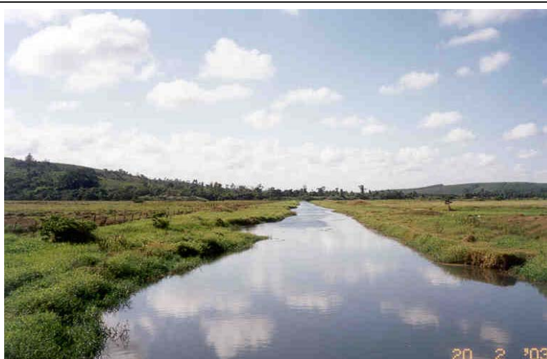
FOTO 10.13 – Rio Piraquê-Açu, a montante do ponto onde será atravessado pelo gasoduto.
