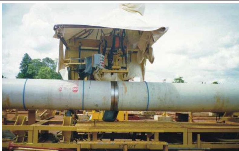
Foto 2.17 – Exemplo de solda Double Joint.
