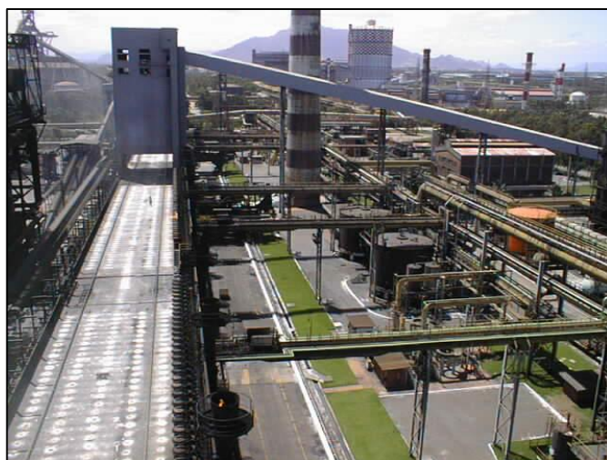
Figura 2.2.4-1: Vista aérea da coqueria da CST.
