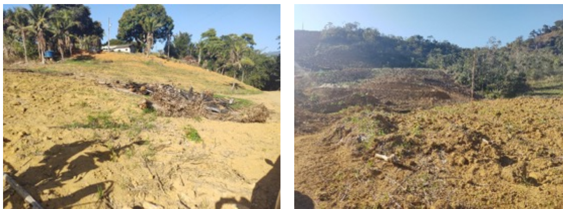
Figura 60. Movimentação de Solo, cortes e taludes irregulares e aterramento de nascentes constituem as principais irregularidades no uso e estão associadas aos loteamentos e parcelamento irregular; Região de Pendanga às margens da BR-101, Foto: Marcos da Costa Martins
